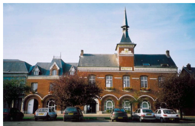
Vue générale. Phot. Gilles-Henri Bailly IVR22_20158005231NUCA
