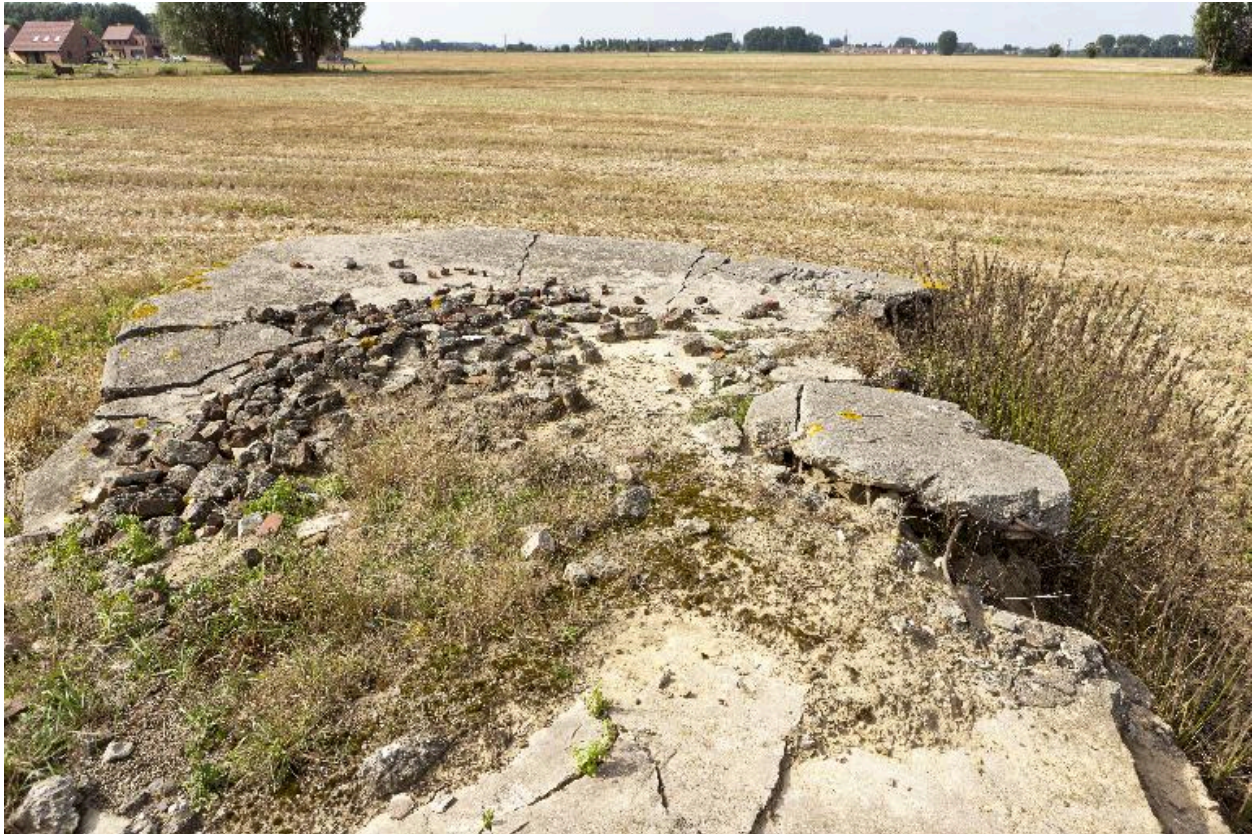
Vue du couvrement, vers l'ouest
