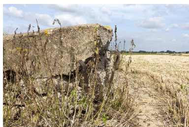
Angle sud-est. Détail Phot. Jean-Marc Ramette IVR31_20145904595NUCA
