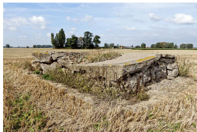
Vue vers le nord-ouest Phot. Jean-Marc Ramette IVR31_20145904589NUCA
