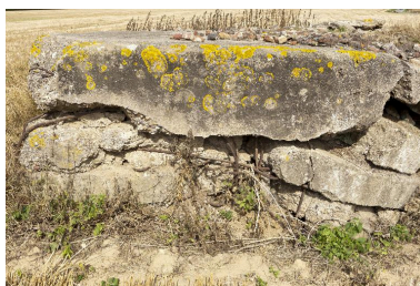
Elévation sud, détail Phot. Jean-Marc Ramette IVR31_20145904590NUCA
