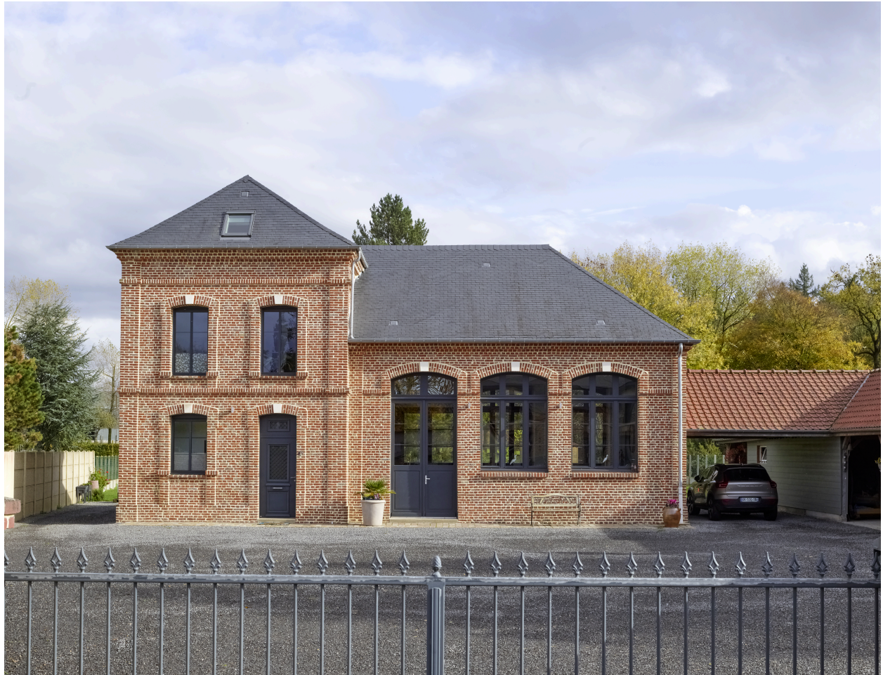
Vue de l'école, depuis l'ouest.
