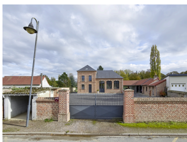
Vue d'ensemble de l'école, depuis l'ouest. Phot. Thierry Lefébure IVR32_20258001592NUCA
