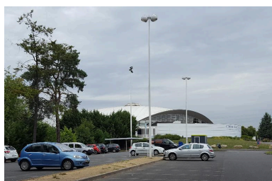
Vue de l'entrée du centre nautique depuis le parking Phot. Laurence Schlosser IVR32_20176005041NUCA
