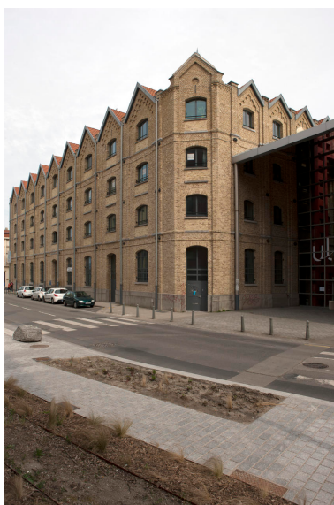
Vue de l'angle de la façade. Phot. Pierre Thibaut IVR31_20135900579NUCA
