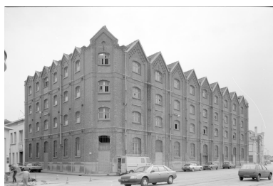
Vue générale, façades sur rue du Gros Jack et quai Freycinet. Phot. Jean-Michel Périn IVR31_19865901805X
