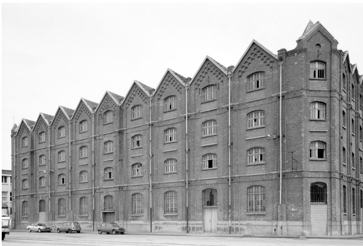
Façade sur quai Freycinet.
