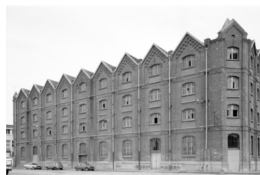
Façade sur quai Freycinet. Phot. Jean-Michel Périn IVR31_19865901804X
