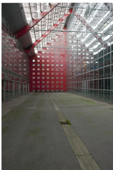
Vue intérieure avant aménagement. Phot. Pierre Thibaut IVR31_20135900463NUCA
