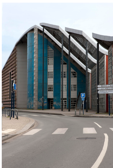
Vue partielle ; entrée du bâtiment. Phot. Pierre Thibaut IVR31_20135900222NUCA
