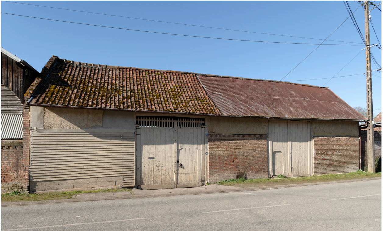
Grange sur rue, n°16 de la rue Yves-Maréchal, vue depuis l'est.
