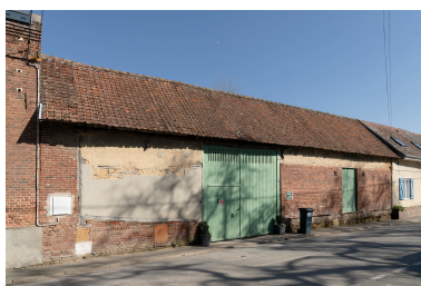
Grange sur rue, n°19 de la rue Yves-Maréchal, vue depuis l'ouest. Phot. Marc Kérignard IVR32_20256000065NUCA
