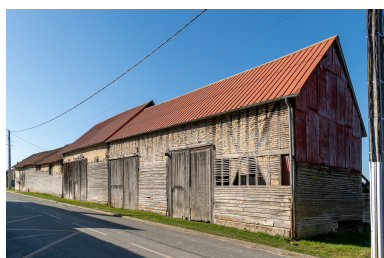
Grange sur rue, n°28 de la rue Yves-Maréchal, vue depuis l'est. Phot. Marc Kérignard IVR32_20256000054NUCA
