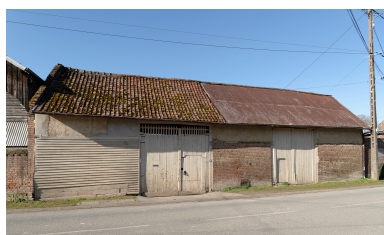
Grange sur rue, n°16 de la rue Yves-Maréchal, vue depuis l'est. Phot. Marc Kérignard IVR32_20256000050NUCA
