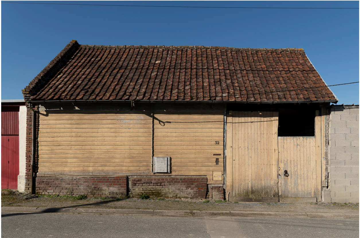
Grange sur rue, n°32 de la rue Yves-Maréchal, vue depuis l'est.
