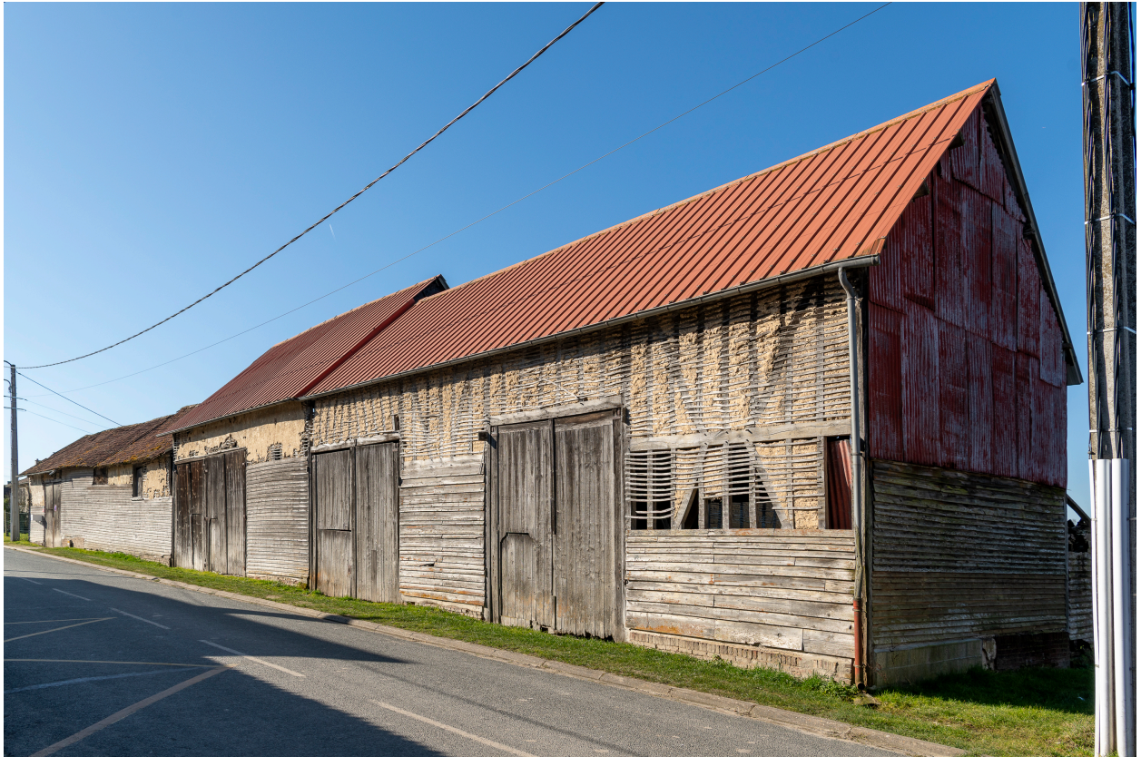
Grange sur rue, n°28 de la rue Yves-Maréchal, vue depuis l'est.
