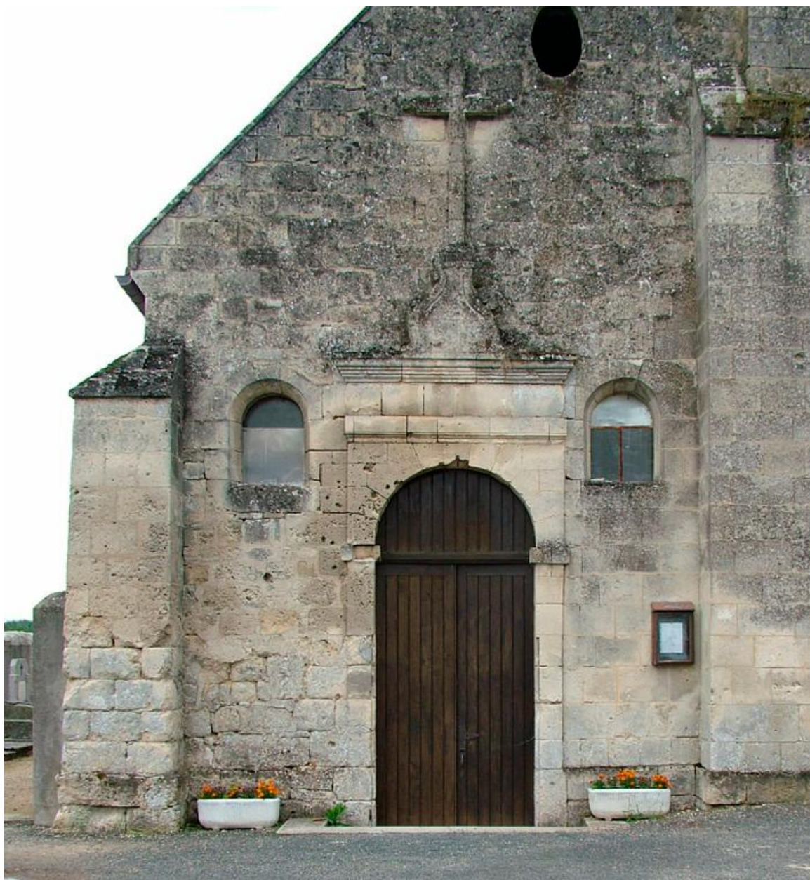
Vue du portail occidental.
