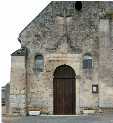
Vue du portail occidental.
