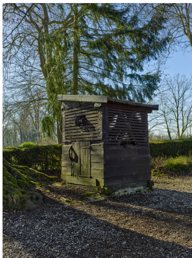
Vue du puits de la ferme dépendant du relais de chasse, depuis le nord.
