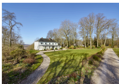
Vue de la maison, depuis l'est. Phot. Thierry Lefébure IVR32_20258000251NUCA
