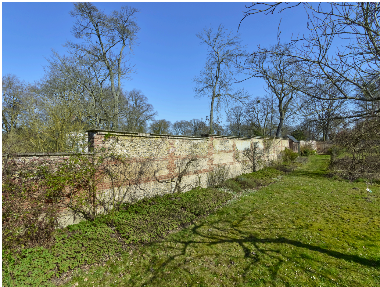
Vue du mur de clôture du potager, depuis le sud.
