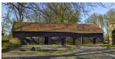
Vue de la grange, dépendant du relais de chasse, depuis le nord-est.
