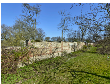
Vue du mur de clôture du potager, depuis le sud. Phot. Thierry Lefébure IVR32_20258000277NUCA
