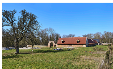
Vue de la ferme XVIIIe, depuis l'est. Phot. Thierry Lefébure IVR32_20258011084NUCA
