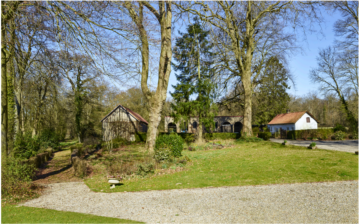
Vue d'ensemble des dépendances du relais de chasse, depuis le sud-est.
