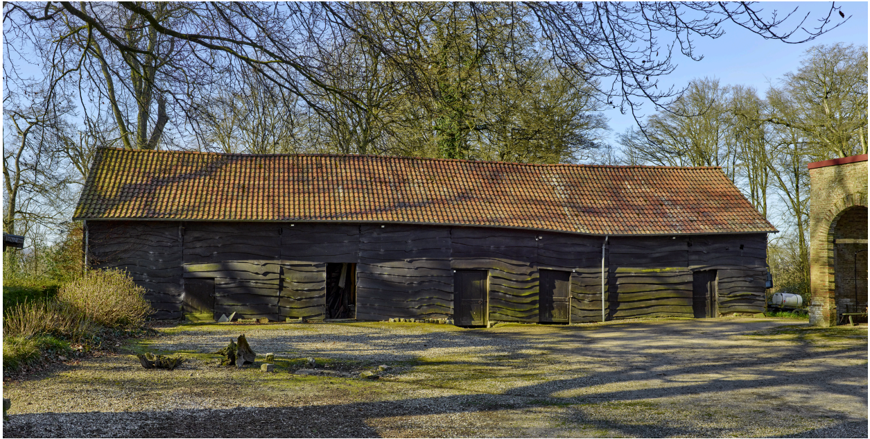
Vue de la grange, dépendant du relais de chasse, depuis le nord-est.
