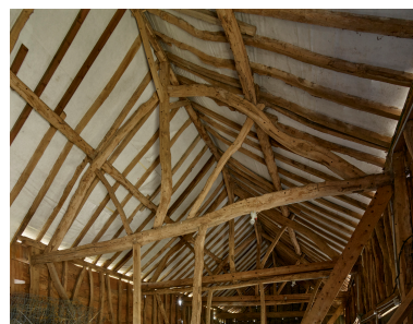
Intérieur, charpente de la grange dépendant du relais de chasse.
