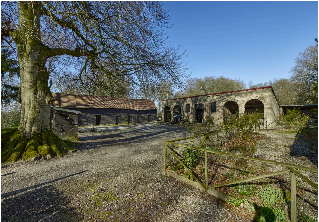
Vue de la cour des dépendances de l'ancien relais de chasse, depuis l'est.
