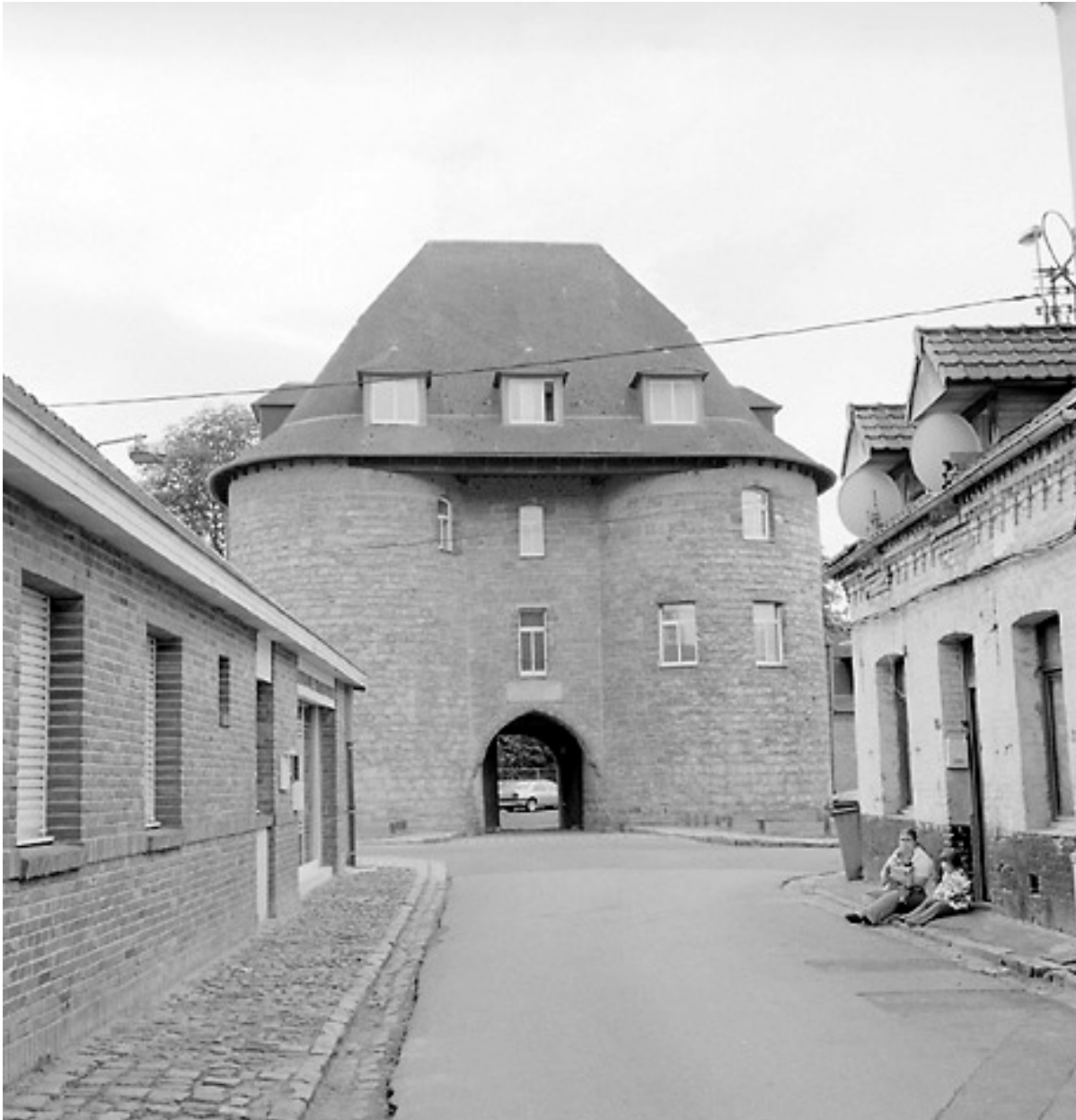
Ouvrage d'entrée, vue frontale dans l'axe de la rue Marcel-Maes (côté ville).
