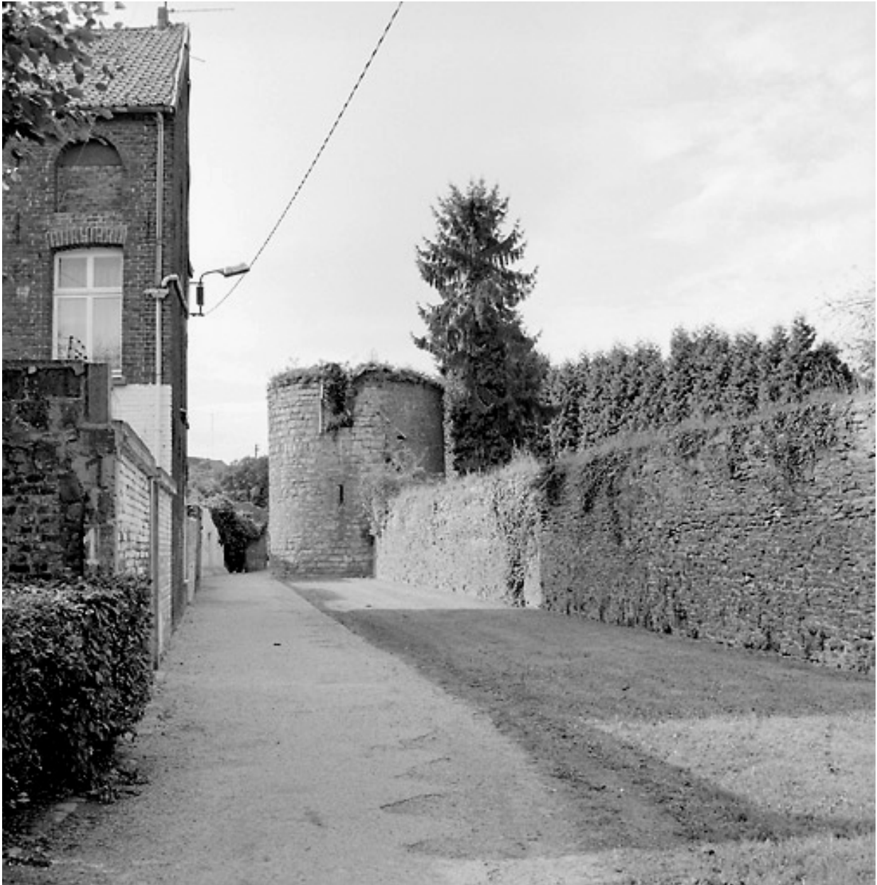
Front est (rue du Chemin-de-Ronde) : vue en enfilade depuis le nord jusqu'à la tour placée en milieu de courtine.
