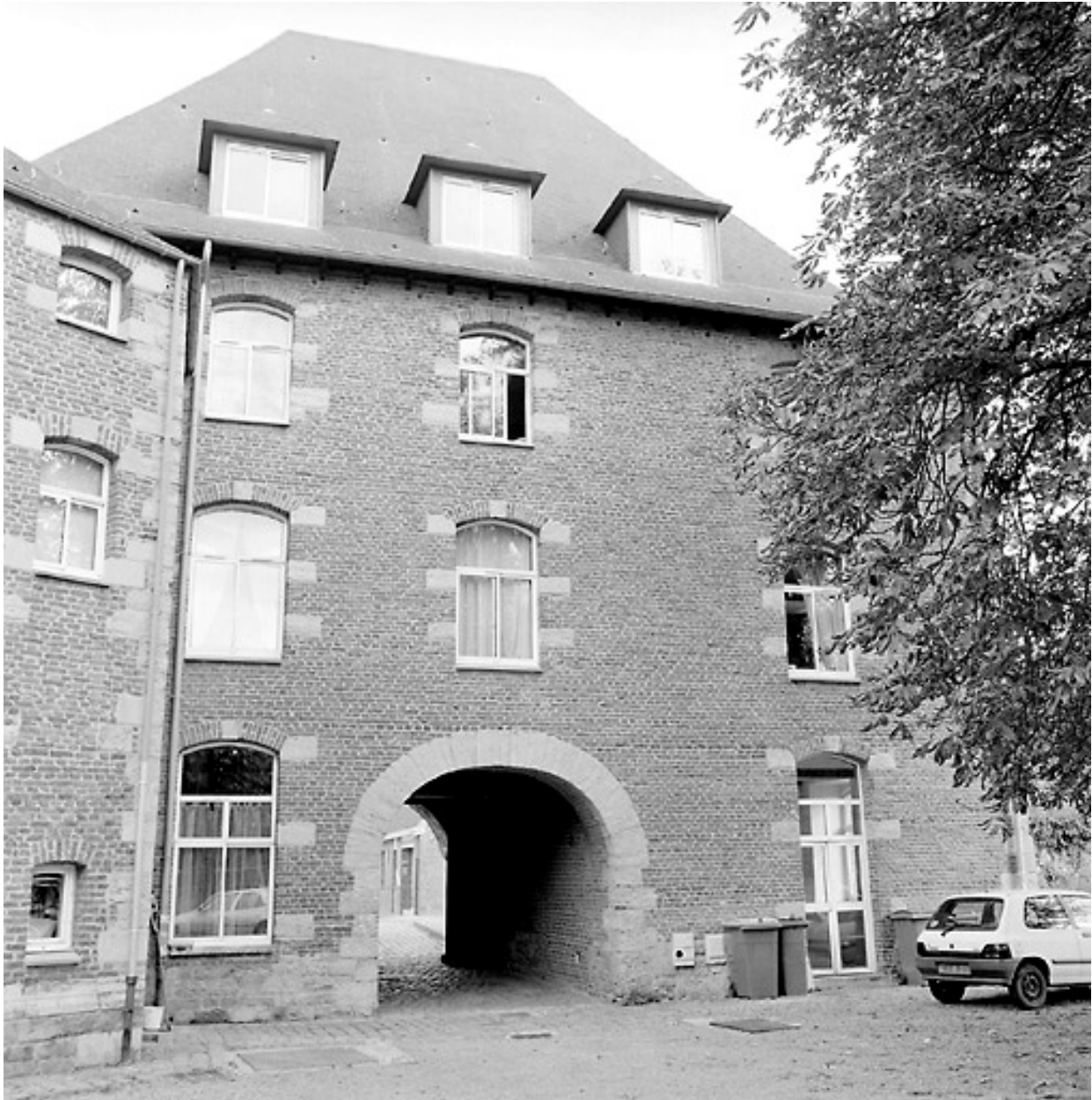
Ouvrage d'entrée, revers, vue générale.
