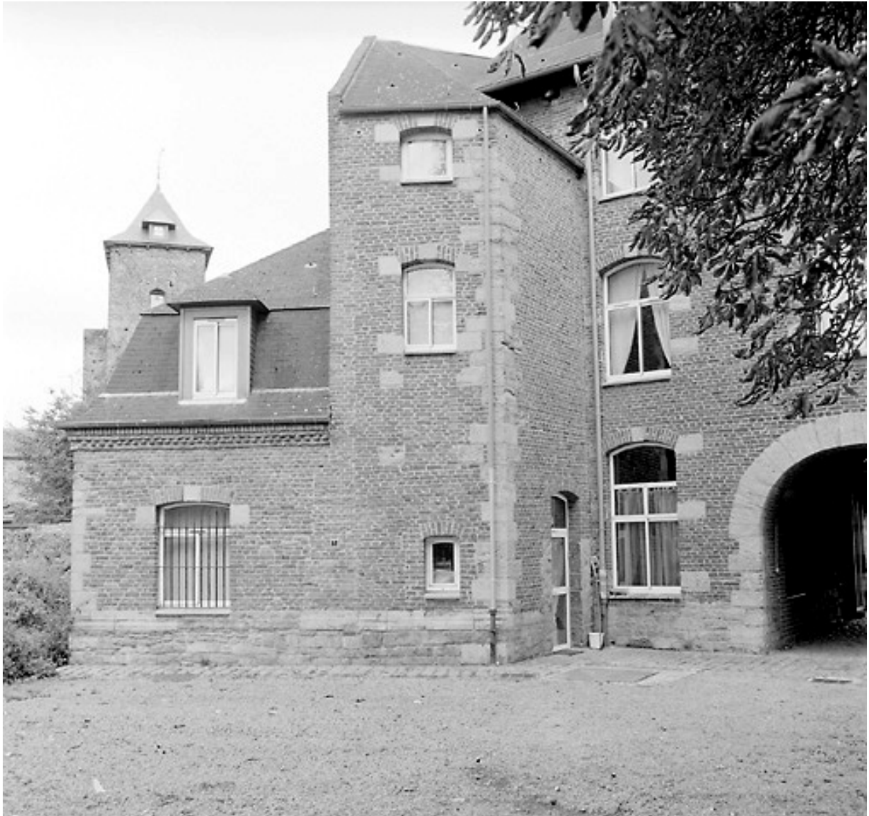
Ouvrage d'entrée, revers, vue partielle avec les vestiges du logis, à gauche.
