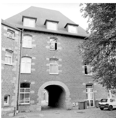
Ouvrage d'entrée, revers, vue générale.
