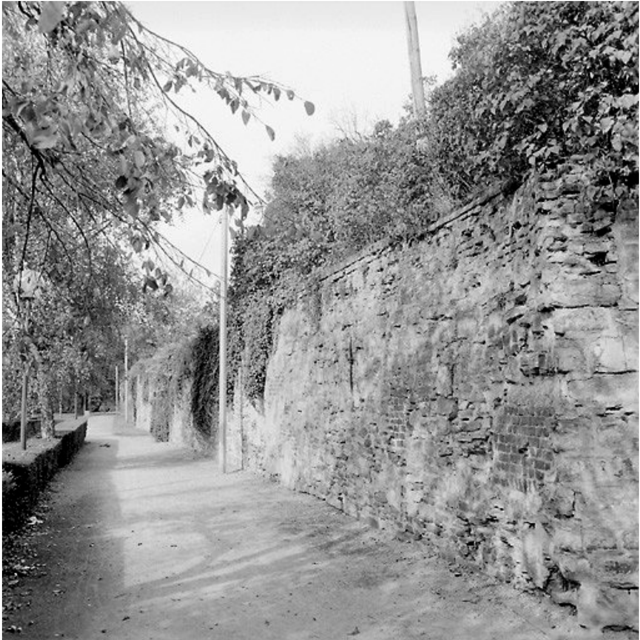
Front sud (square de l'Escaut) : vue générale de la courtine depuis le sud-est.
