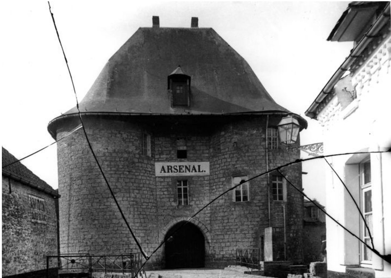
Ouvrage d'entrée, vue d'ensemble côté ville, vers 1900 (Courtine nord du château, baignée par la Haynette, vers 1900 ; au fond la tour du moulin (Douai - Musée de la Chartreuse - Photothèque Augustin Boutique-Grard).
