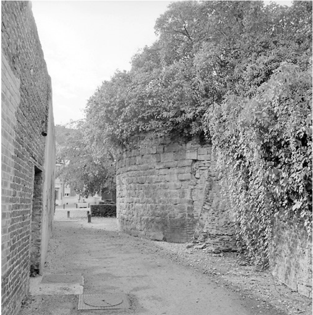
Front est (rue du Chemin-de-Ronde) : vue en enfilade depuis le nord jusqu'à la tour de l'angle sud-est.
