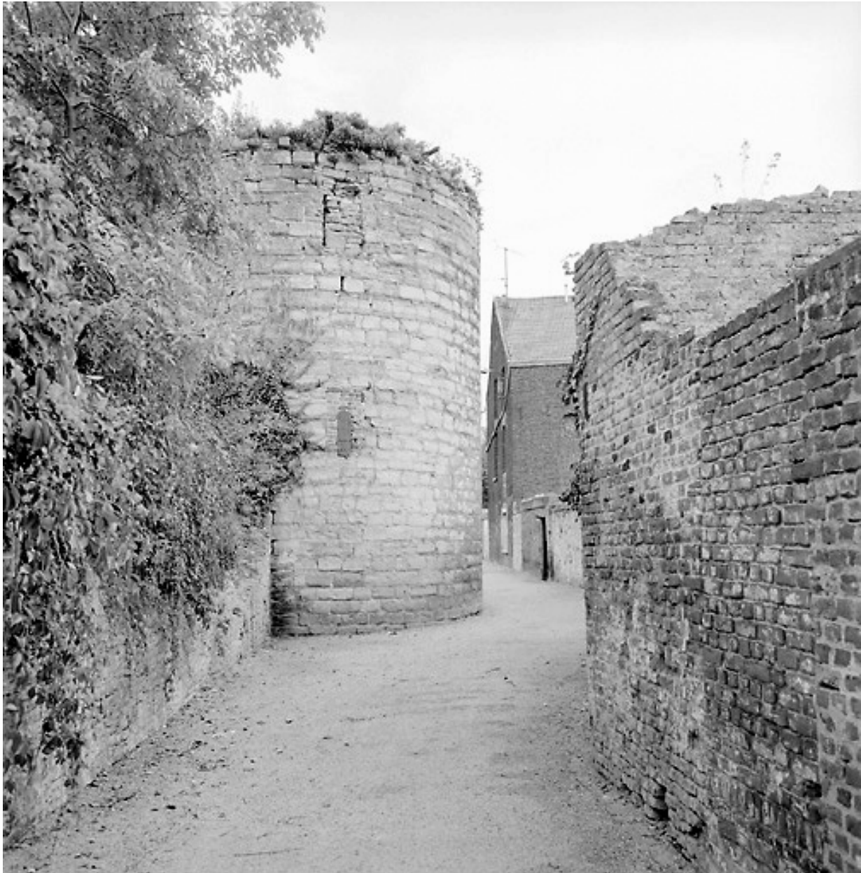
Front est (rue du Chemin-de-Ronde) : vue en enfilade depuis le sud ; à gauche, la tour médiane.
