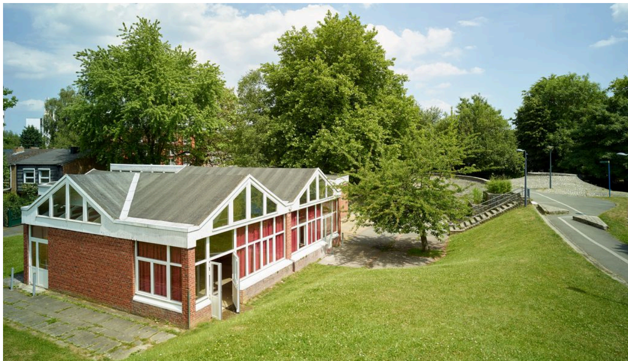
La cantine scolaire depuis le chemin des Tziganes.
