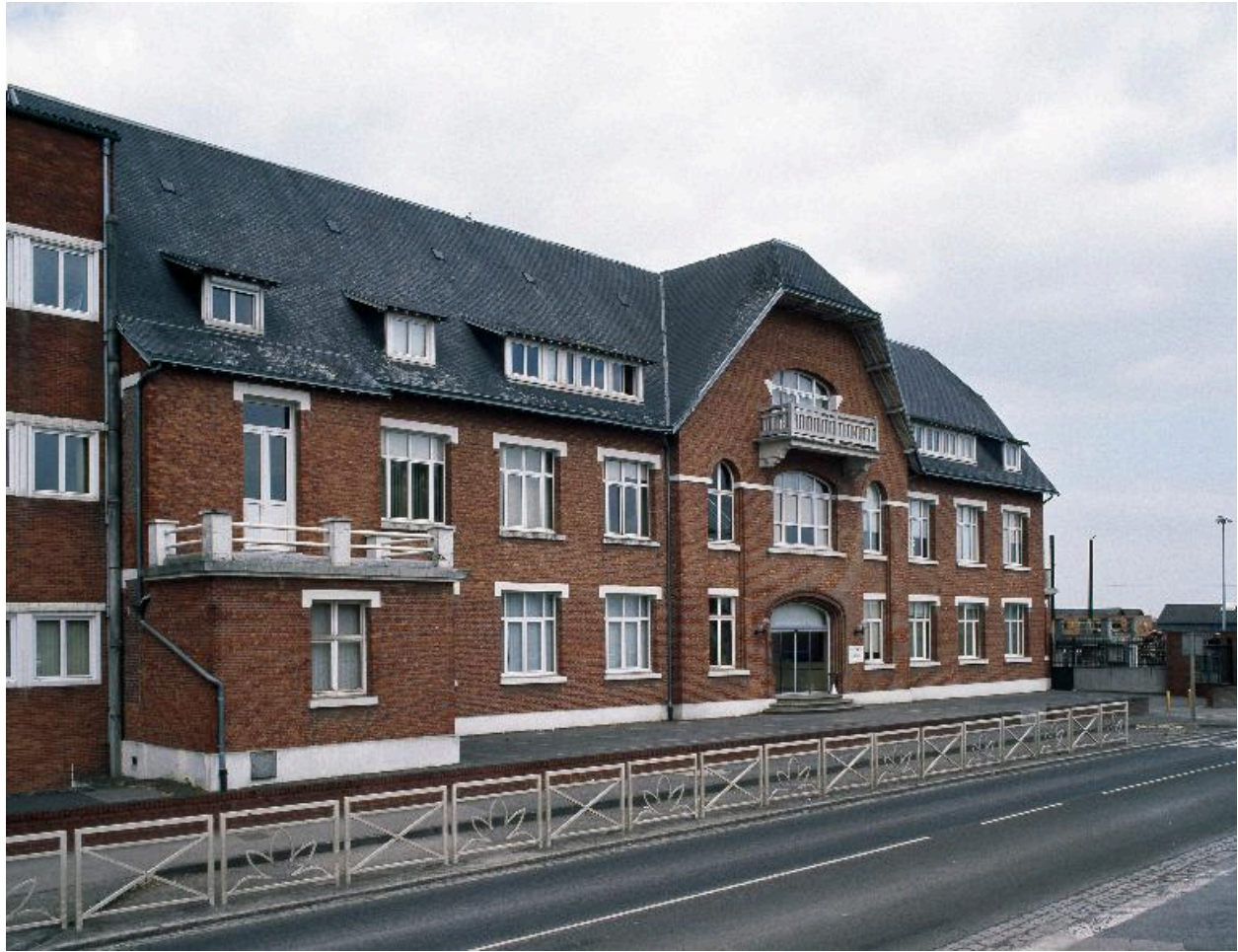
Vue d'ensemble de la façade sur rue des bureaux de la sucrerie.
