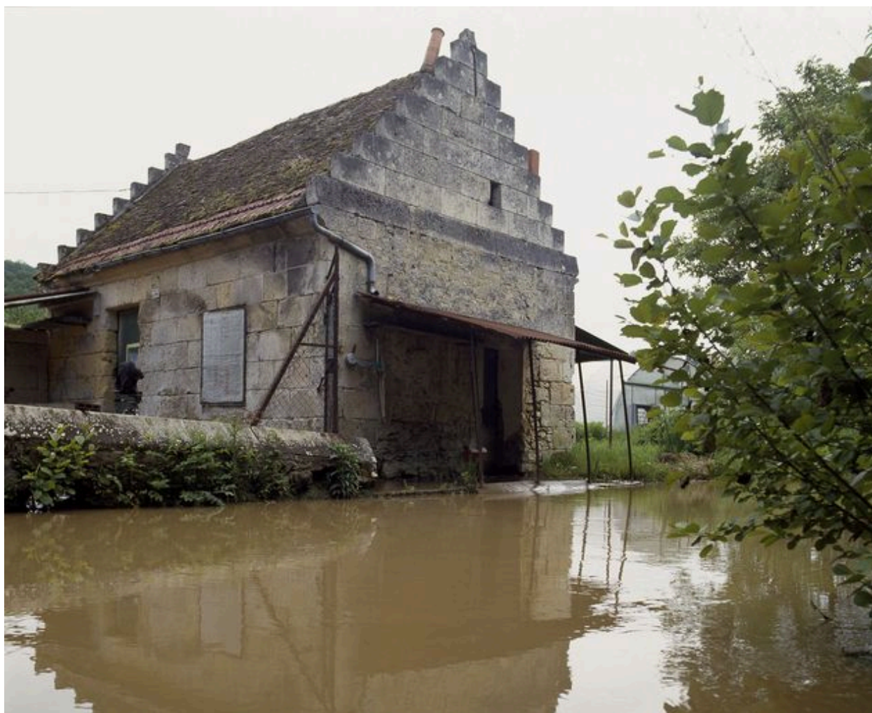
Le bassin de retenue.
