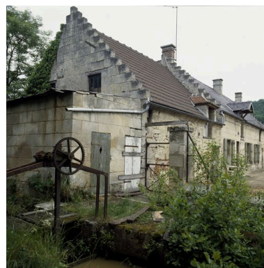
Bâtiment d'eau. Phot. Olivier Coquelle IVR22_19946001200XA
