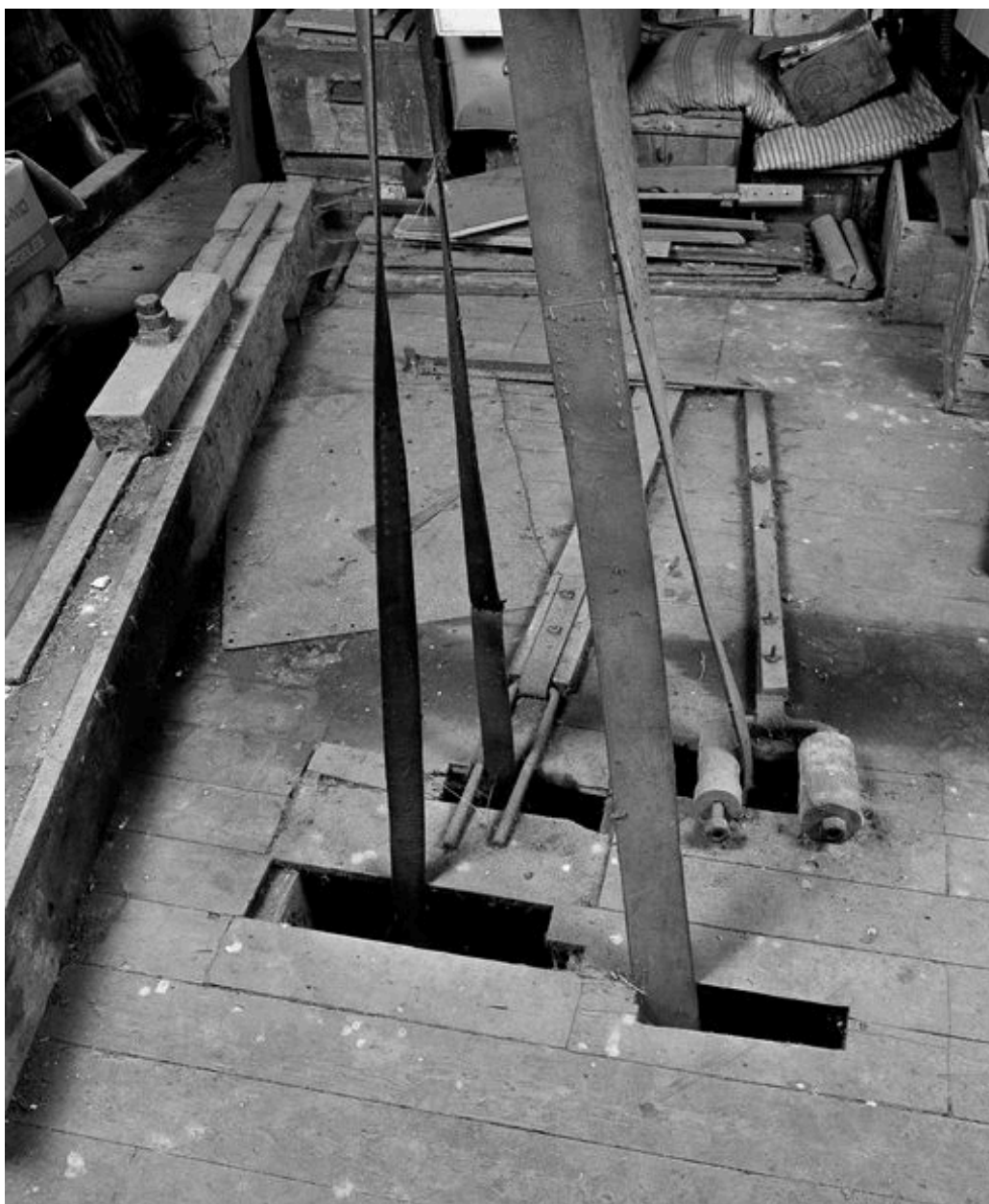
Courroies de transmission, en comble.
