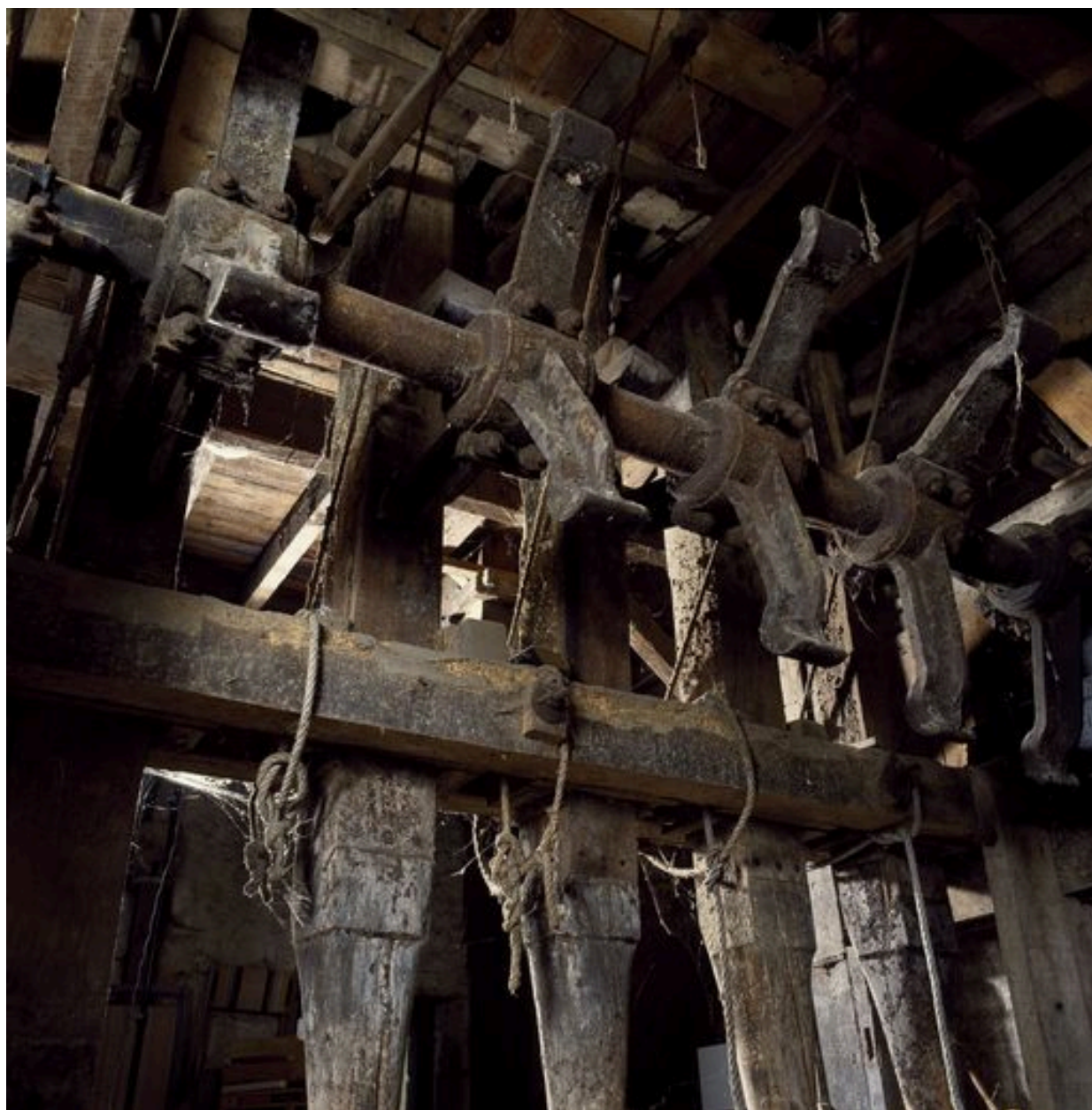
Détail du palier de la roue hydraulique.
