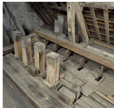
Détail des battoirs (en comble). Phot. Olivier Coquelle IVR22_19946001197XA
