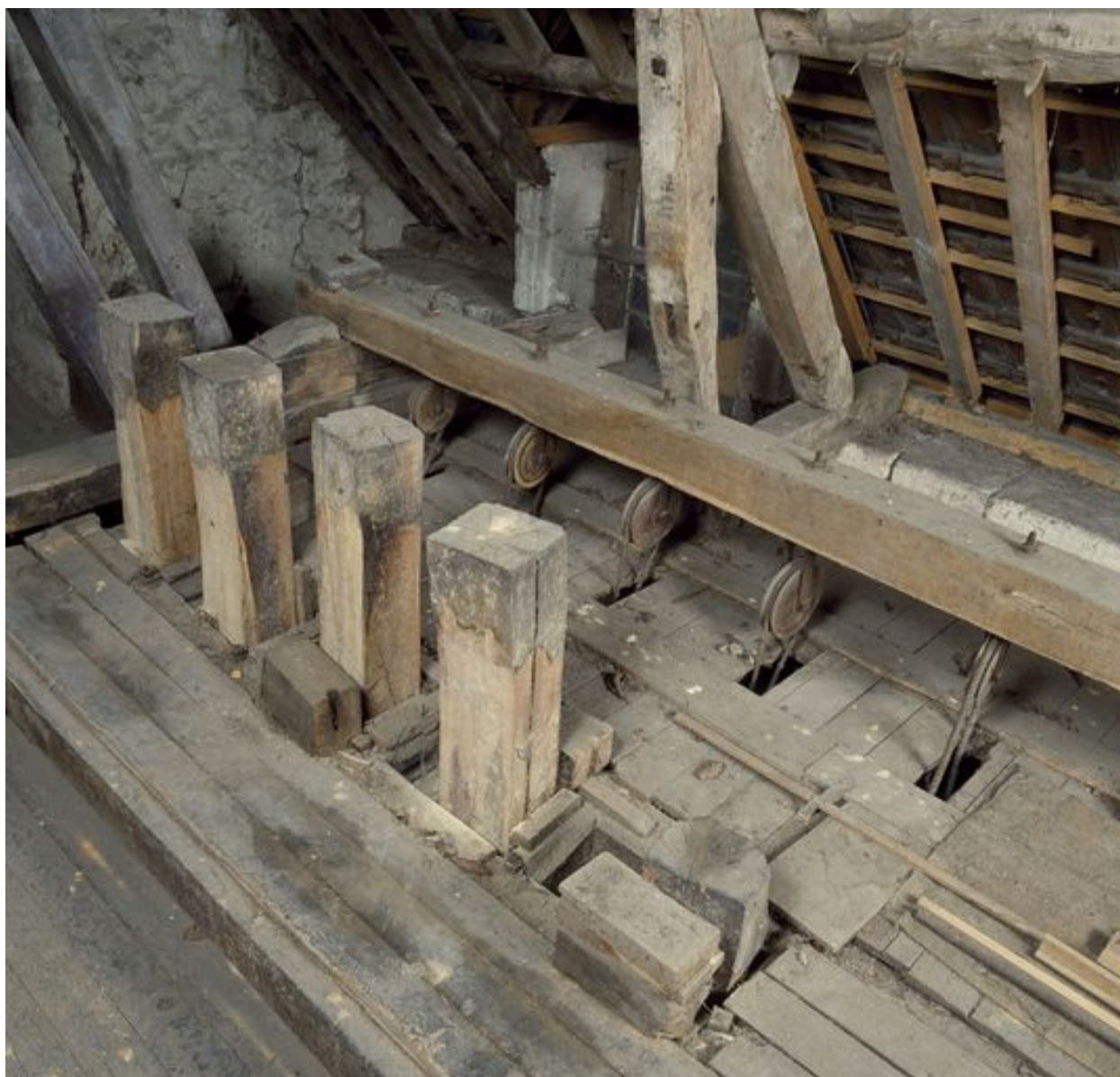
Détail des battoirs (en comble).
