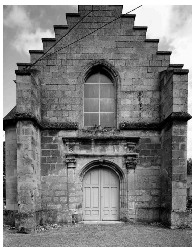
Façade occidentale. Phot. Jean-Michel Périn IVR22_19856001022V
