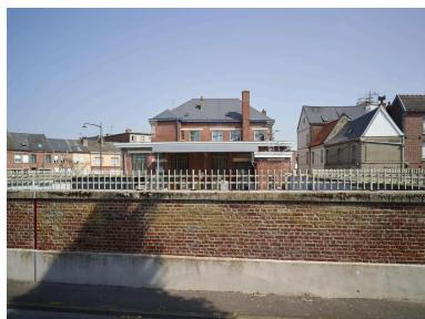
Façade arrière et mur- bahut entourant la cour. Phot. Pierre Thibaut IVR32_20235900968NUCA
