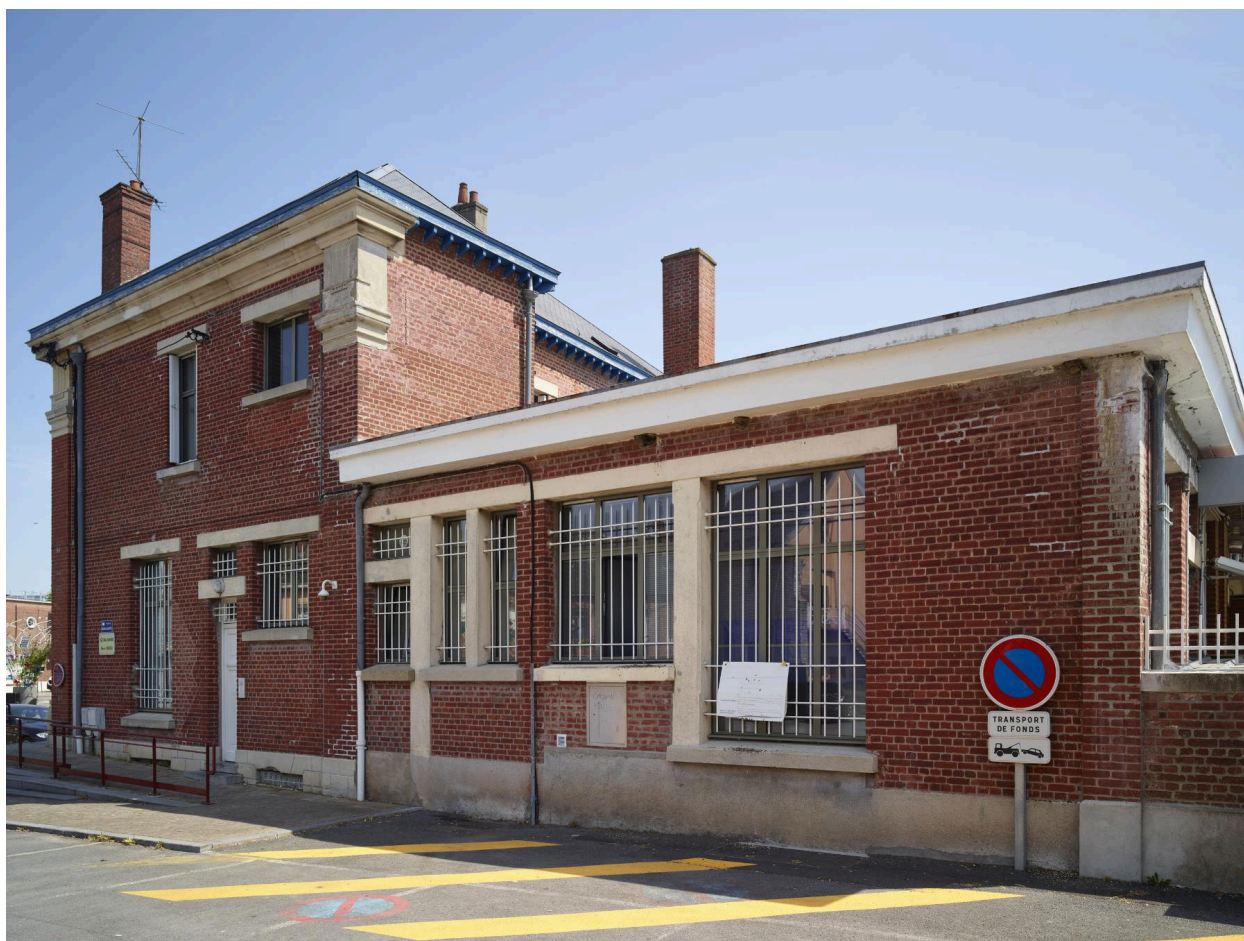
Poste : façade latérale est. Vue orientée nord/sud.
