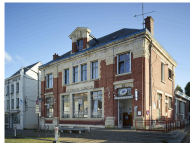
Poste : façade sur la place du Général-Leclerc et mur latéral droit. Vue orientée sud/nord. Phot. Pierre Thibaut IVR32_20245902557NUCA
