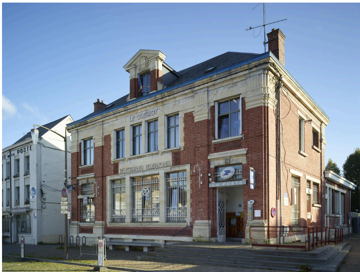
Poste : façade sur la place du Général-Leclerc et mur latéral droit. Vue orientée sud/nord.
