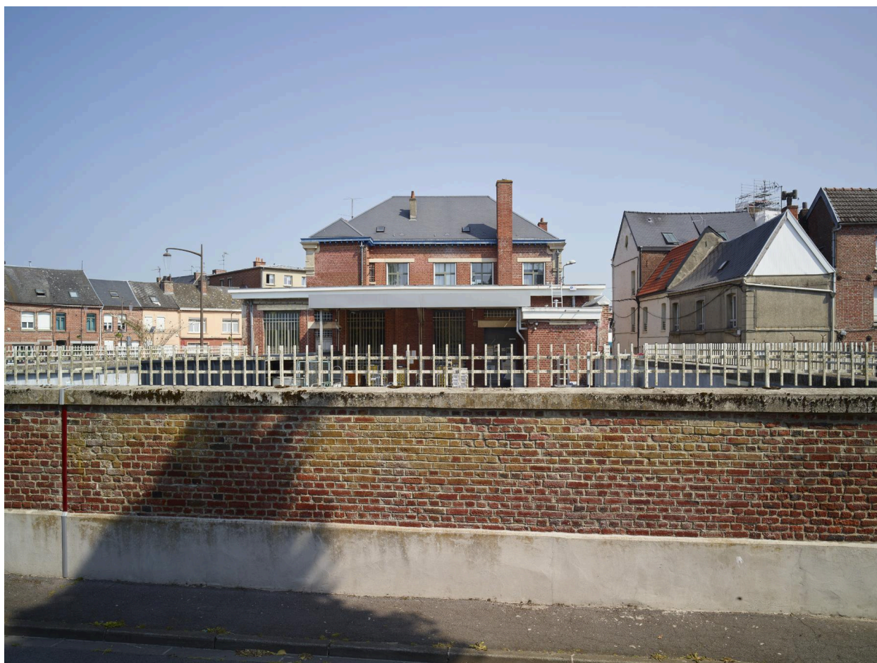
Façade arrière et mur-bahut entourant la cour.
