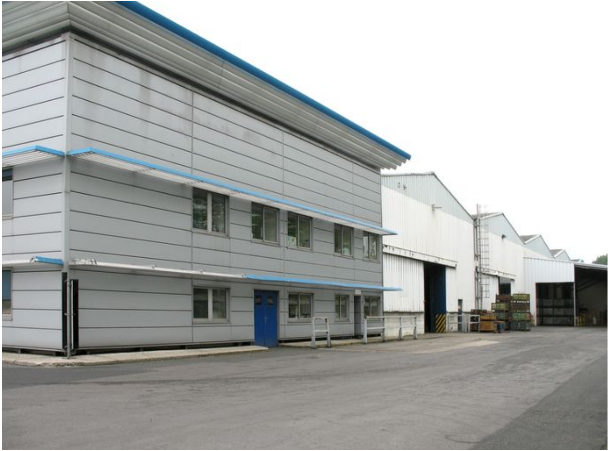
Les bureaux et les ateliers de fabrication.
