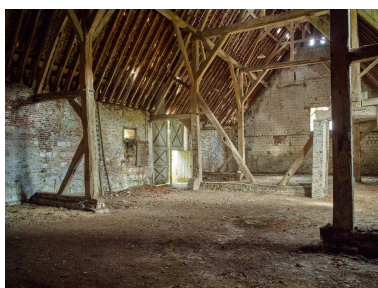
Fermes des Berceaux : grange monastique : détail du système d'entretoises qui a permis la datation.
