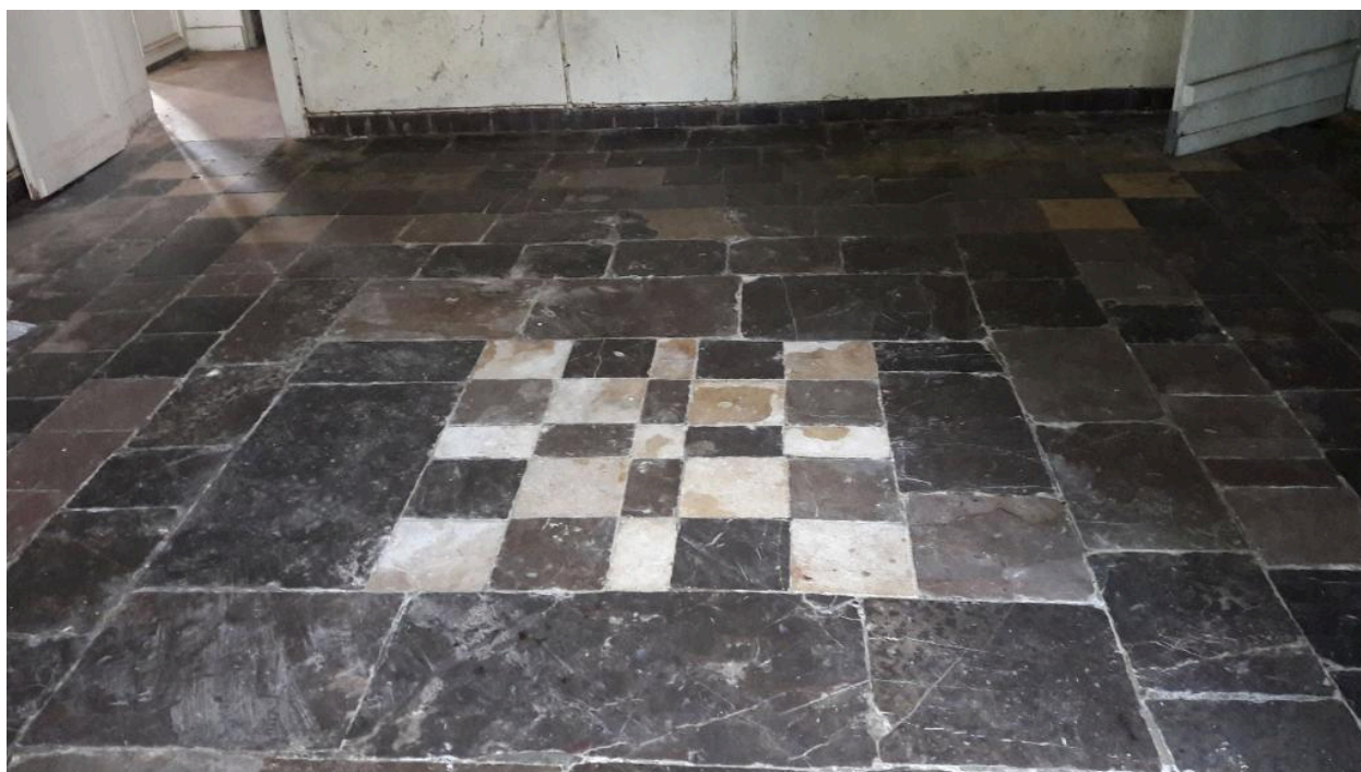
Ferme des berceaux : détail du dallage de la laiterie associant pierre bleue et calcaire blanc. (Coll. part.)
