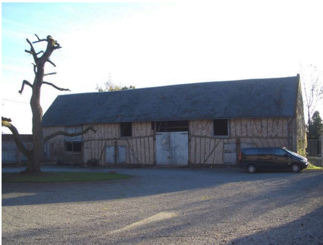
Vue de la grange au sud.
