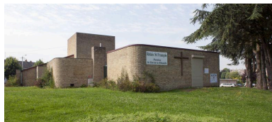
Élévation nord. Phot. Pierre Thibaut IVR31_20155900716NUCA
