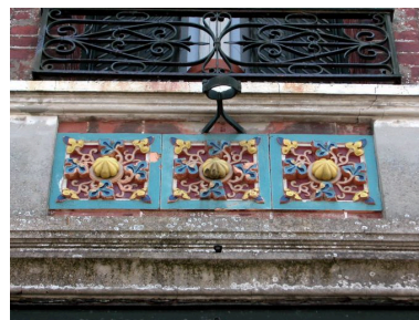
Détail d'un panneau d'allège en céramique. Phot. Elisabeth Justome IVR22_20058002874NUCA
