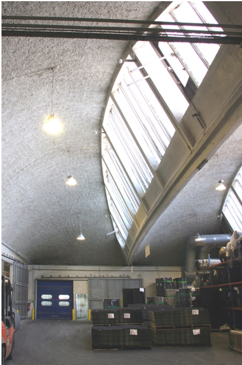
Ancien atelier de fabrication : un shed.
