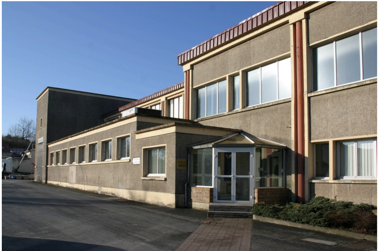
Cour de l'usine : entrée des bureaux.
