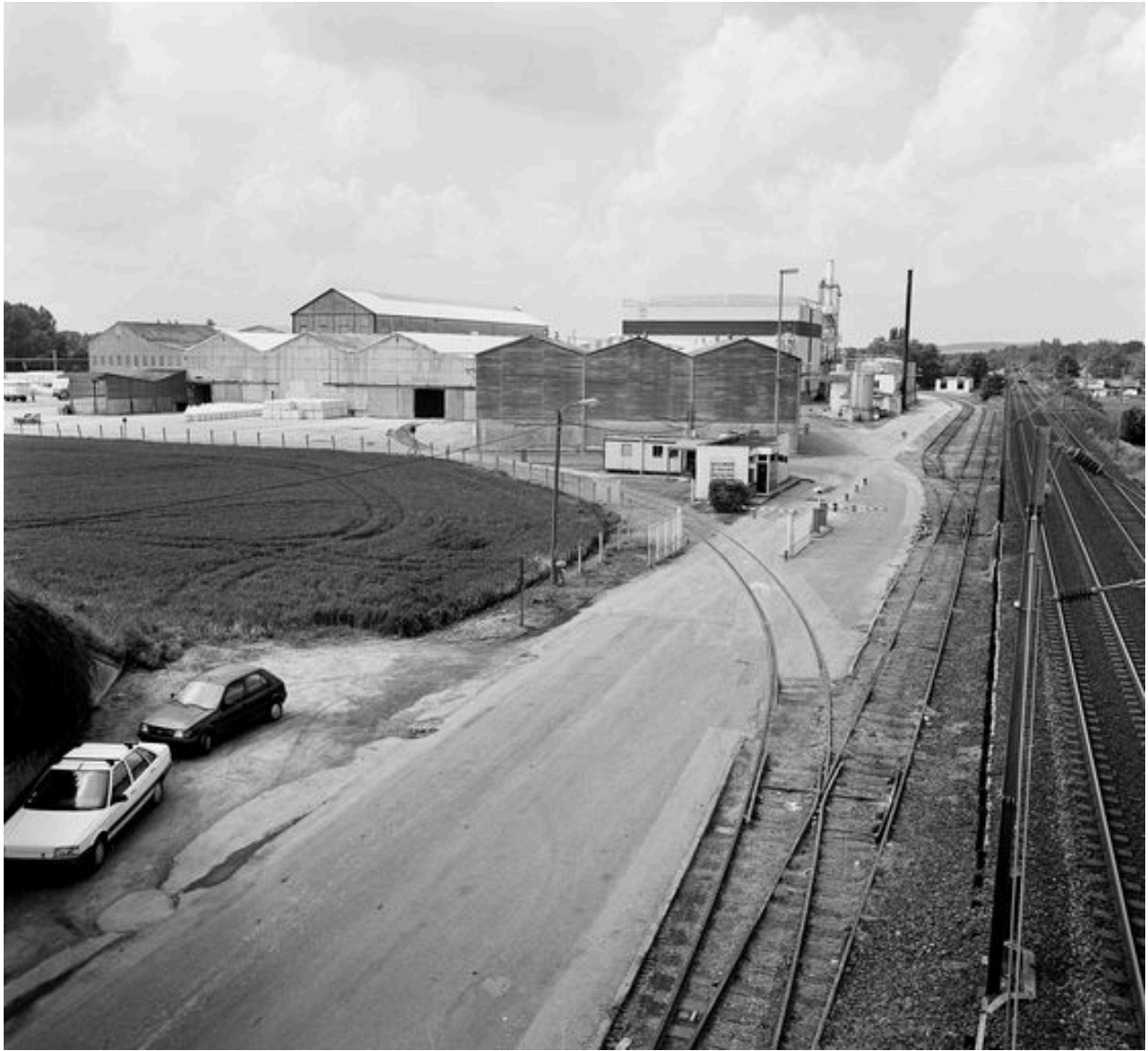
Vue d'ensemble nord.
