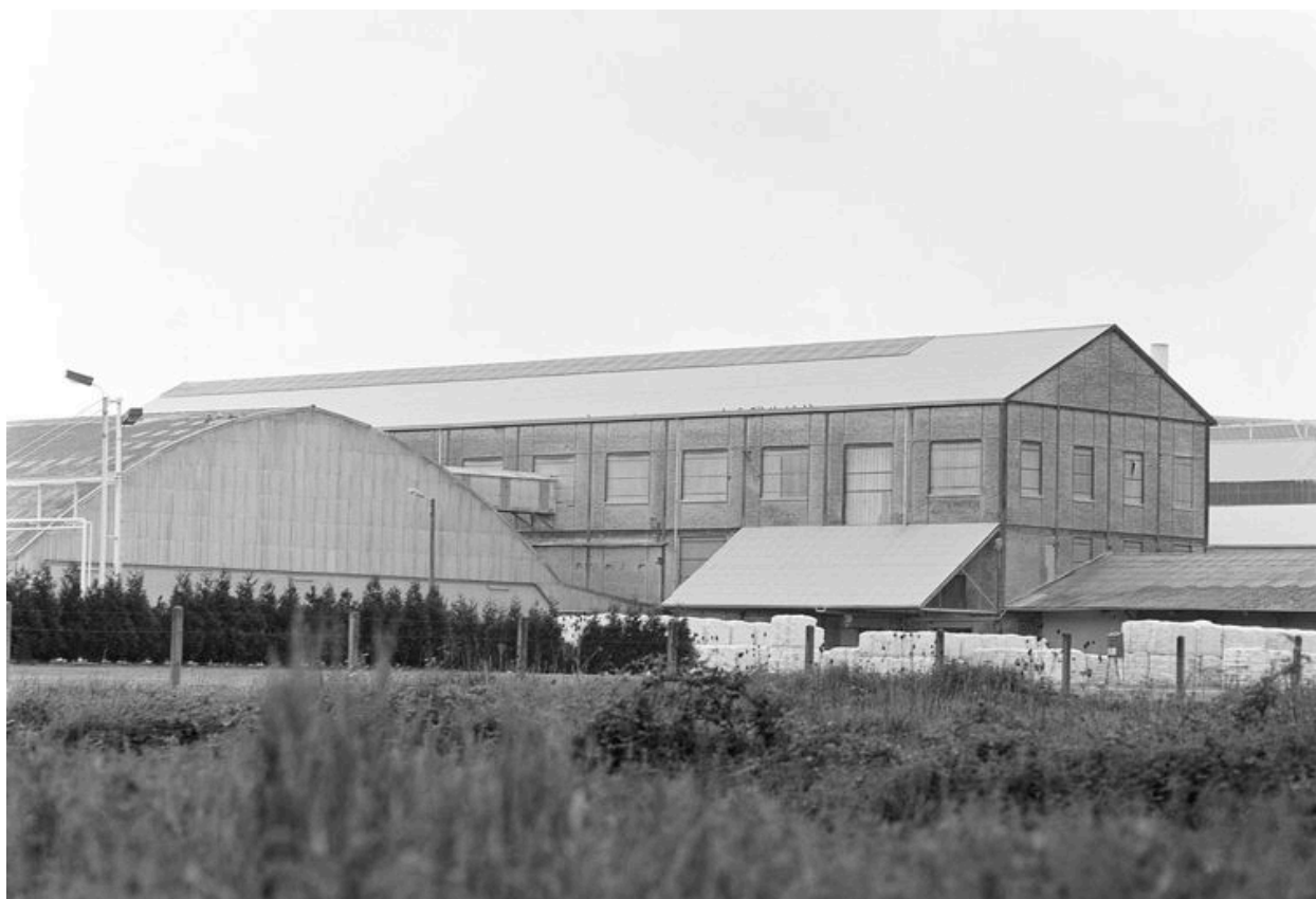
Vue d'ensemble est.
