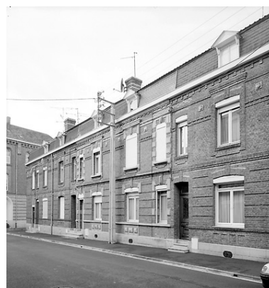
Rang nord-ouest, extrémité vers la rue du Maréchal-de-Croÿ : maisons n° 1 à 11. Phot. Pierre Thibaut IVR31_20015900033V
