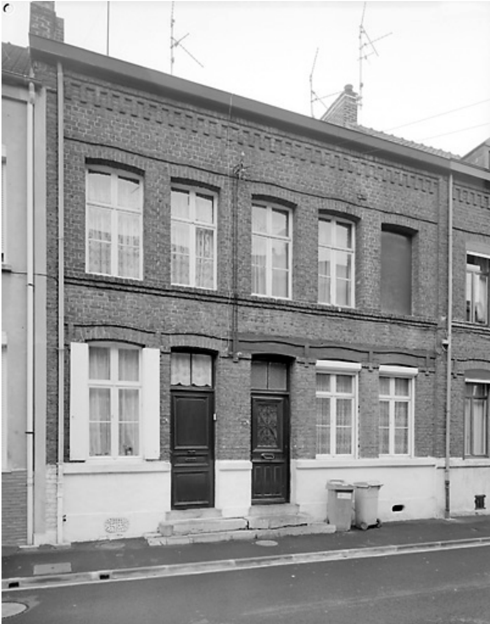
Rang sud-est : maisons n° 10 et 12.
