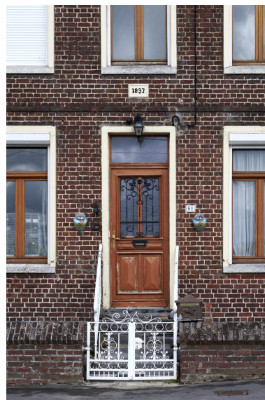
Porte d'entrée, date portée "1897". Phot. Delphine Volto Jourdan IVR32_20245903217NUCA
