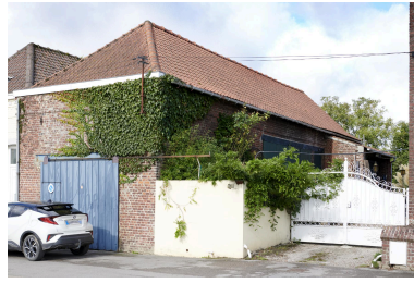
Bâtiment agricole à gauche du logis. Phot. Delphine Volto Jourdan IVR32_20245903219NUCA
