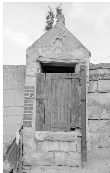
Puits d'une ferme repérée (section B4 1098).
