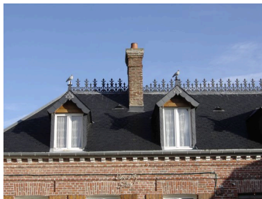
Vue détaillée de la crête en zinc.
