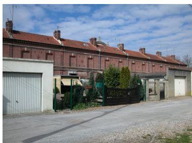
Corps de bâtiment nord, façade postérieure. Phot. Bertrand Fournier IVR22_20046002855NUCA
