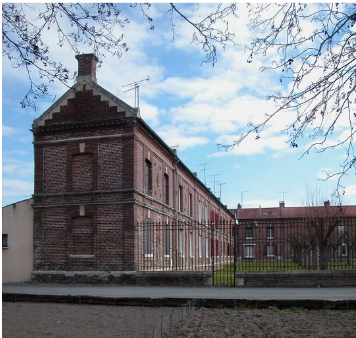
Vue d'ensemble du corps de bâtiment ouest.
