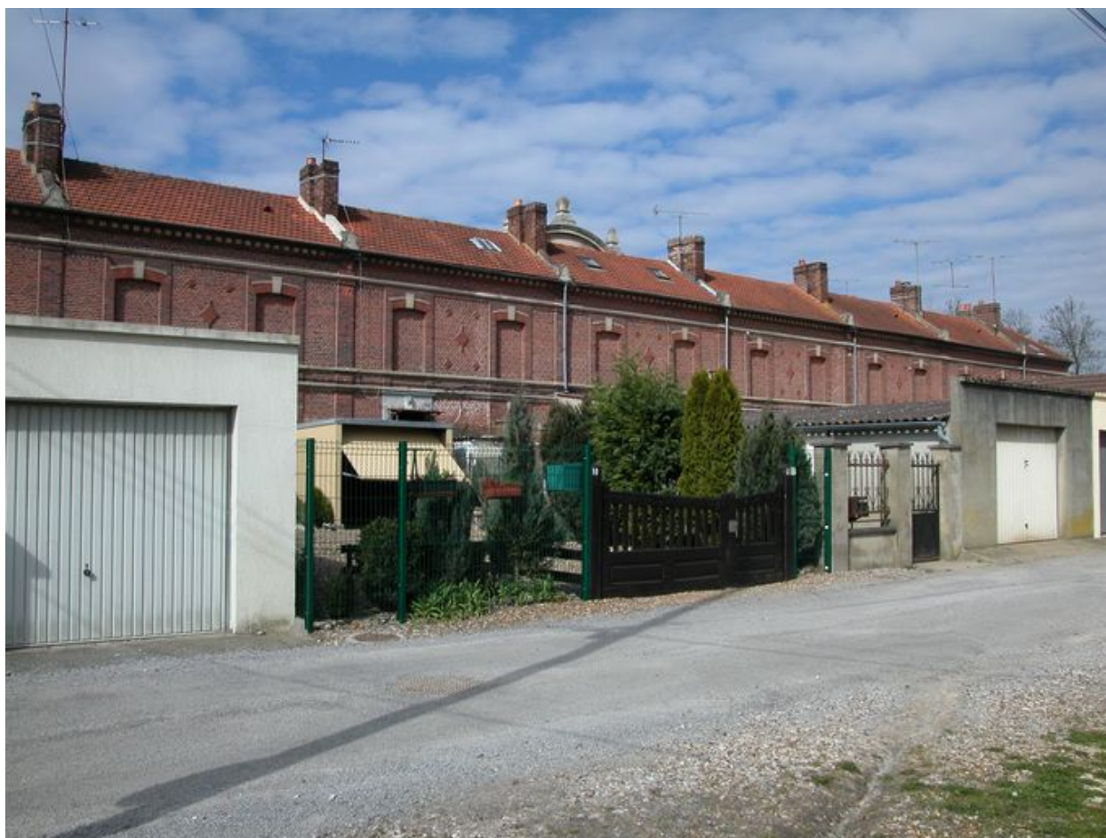
Corps de bâtiment nord, façade postérieure.
