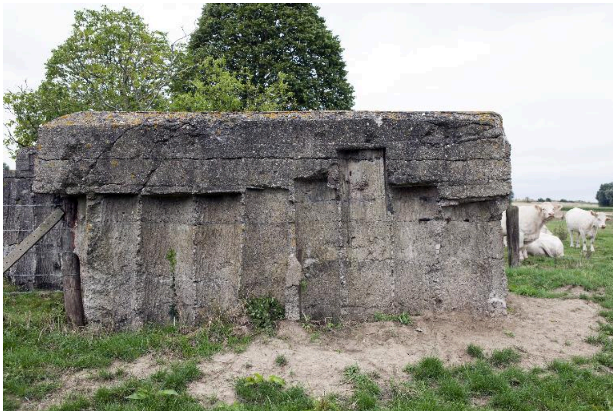
Partie sud de l'édifice, vers le nord
