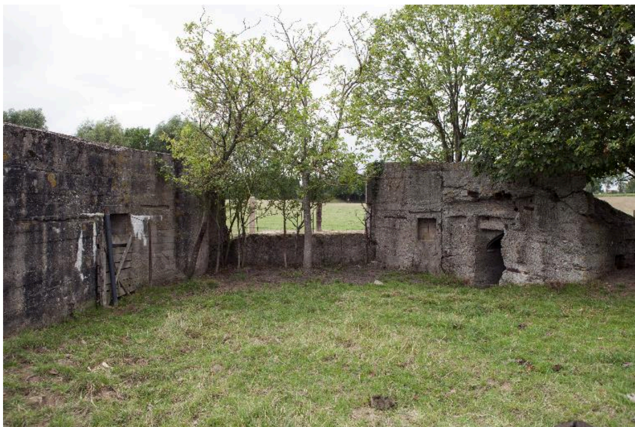
Vue vers l'ouest, dans l'alignement du canon
