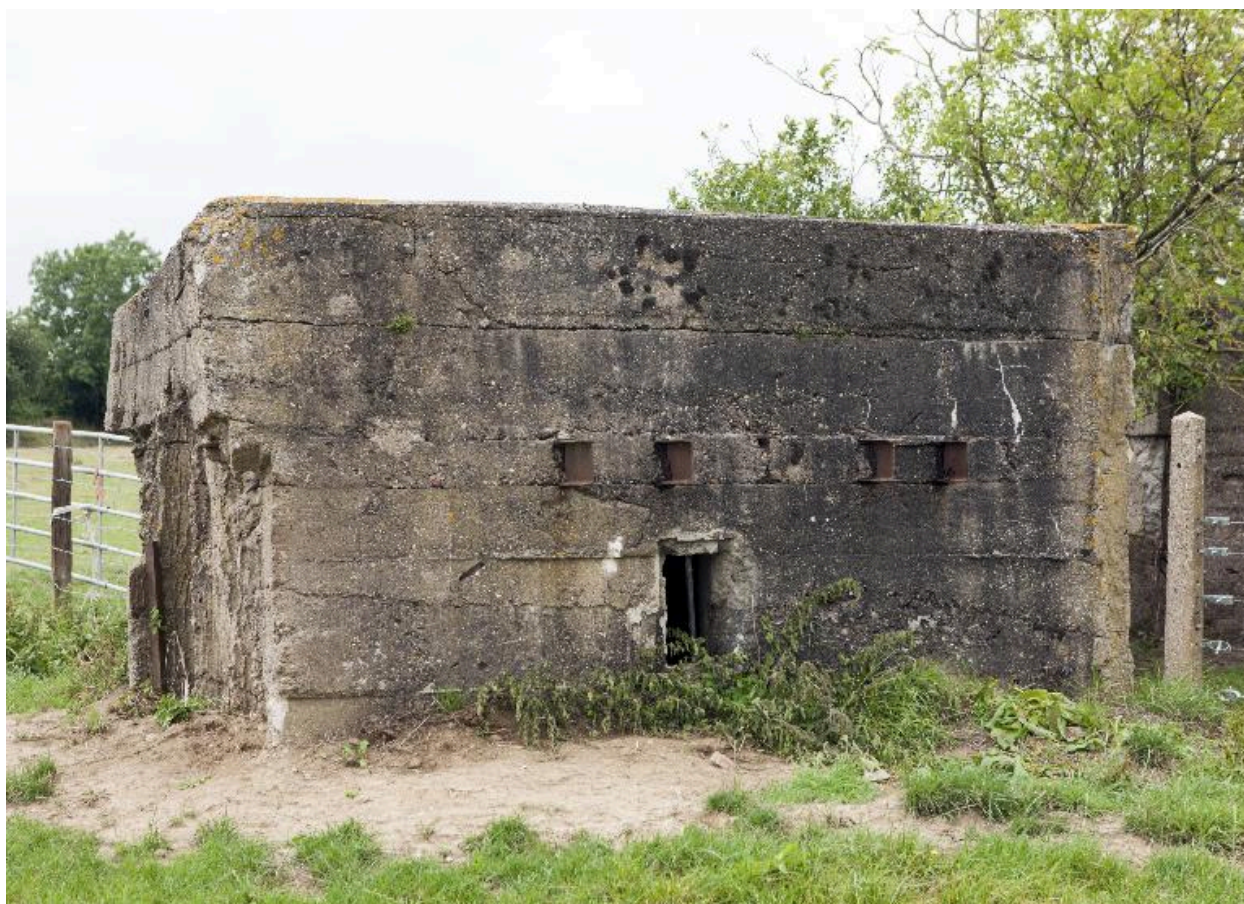
Partie sud de l'édifice, vers le nord-ouest
