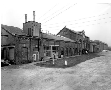
Chaudière, salle des machines (bâtiments 2a et 7), en 1988 : élévation sud-ouest. Phot. Thierry Lefébure IVR22_19888000464V
