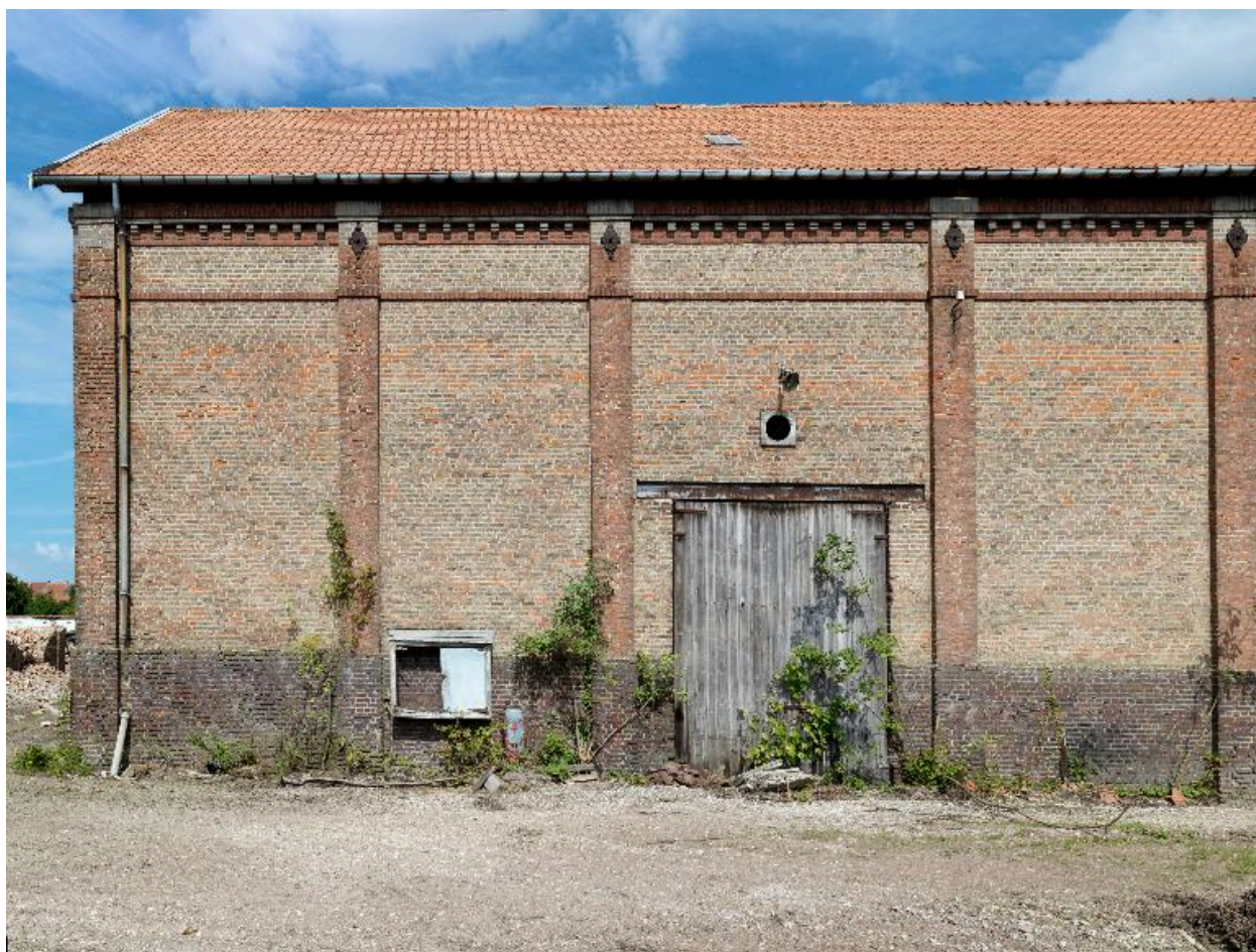
Elévation longitudinale partielle des entrepôts, juillet 2012.
