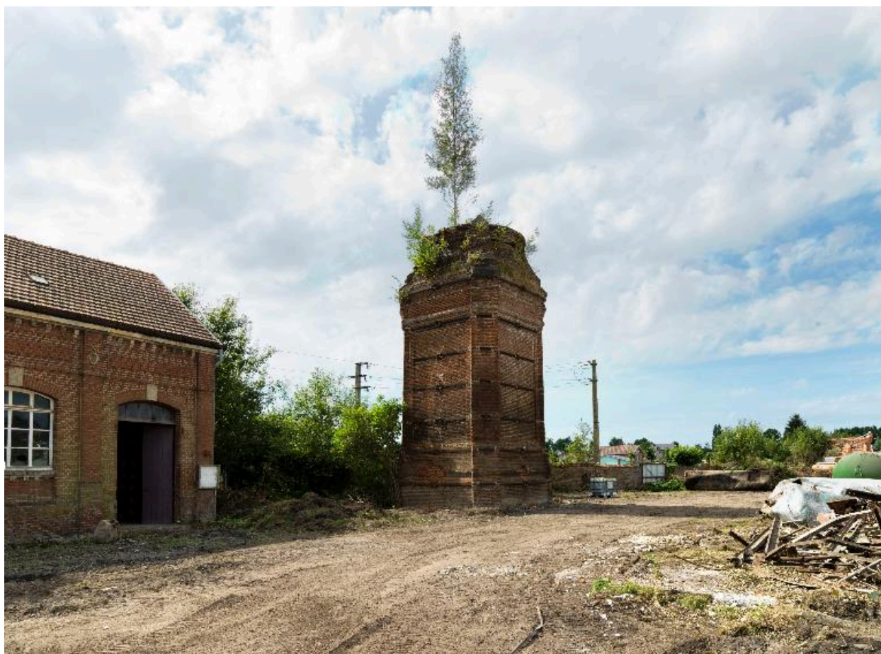
Vestiges de la cheminée de l'usine, juillet 2012.
