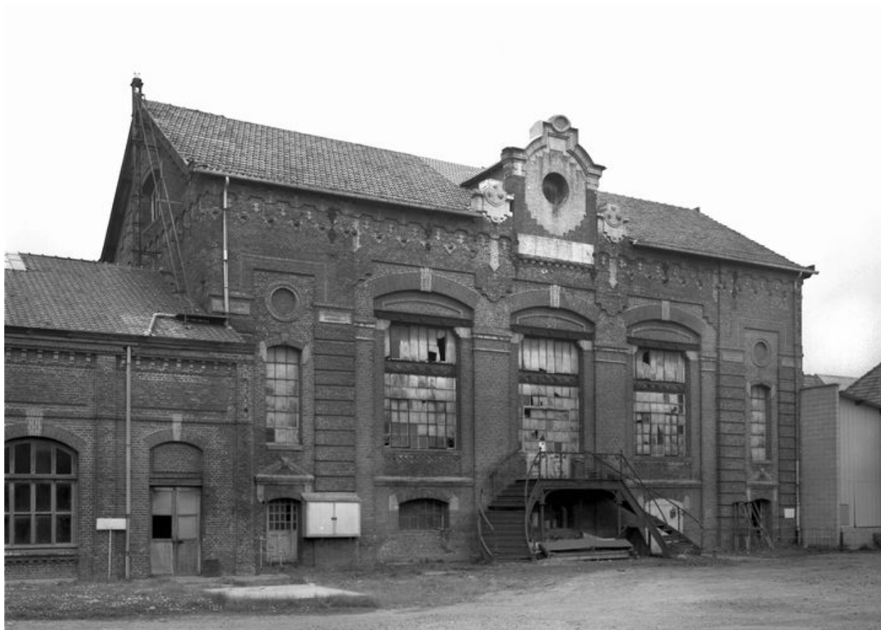
Salle des machines (bâtiment 7), en 1988 : élévation antérieure.
