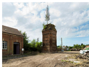
Vestiges de la cheminée de l'usine, juillet 2012.
