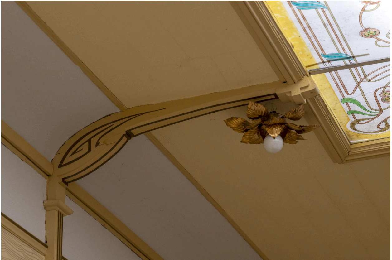
Détail d'un des luminaires de la salle à manger : potence et plafonnier.
