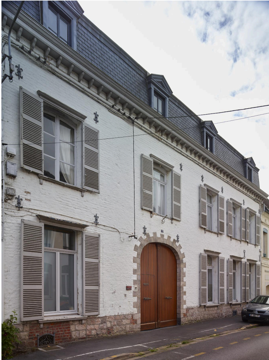
Façade principale sur la rue Brancion.
