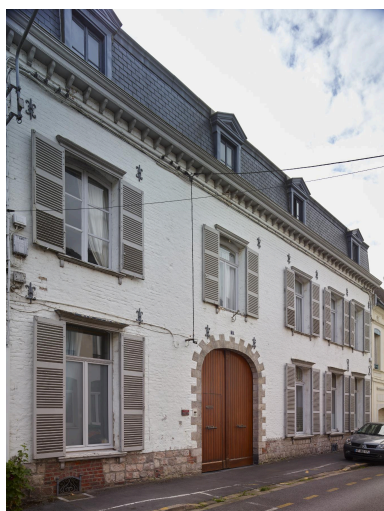
Façade principale sur la rue Brancion. Phot. Pierre Thibaut IVR32_20245900334NUCA
