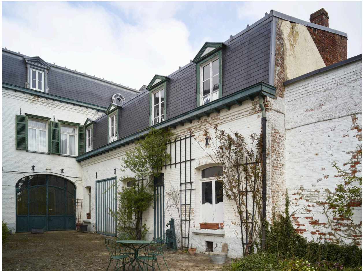
Détail de l'aile des communs et de l'arrière de la porte cochère (aile est) depuis la cour.
