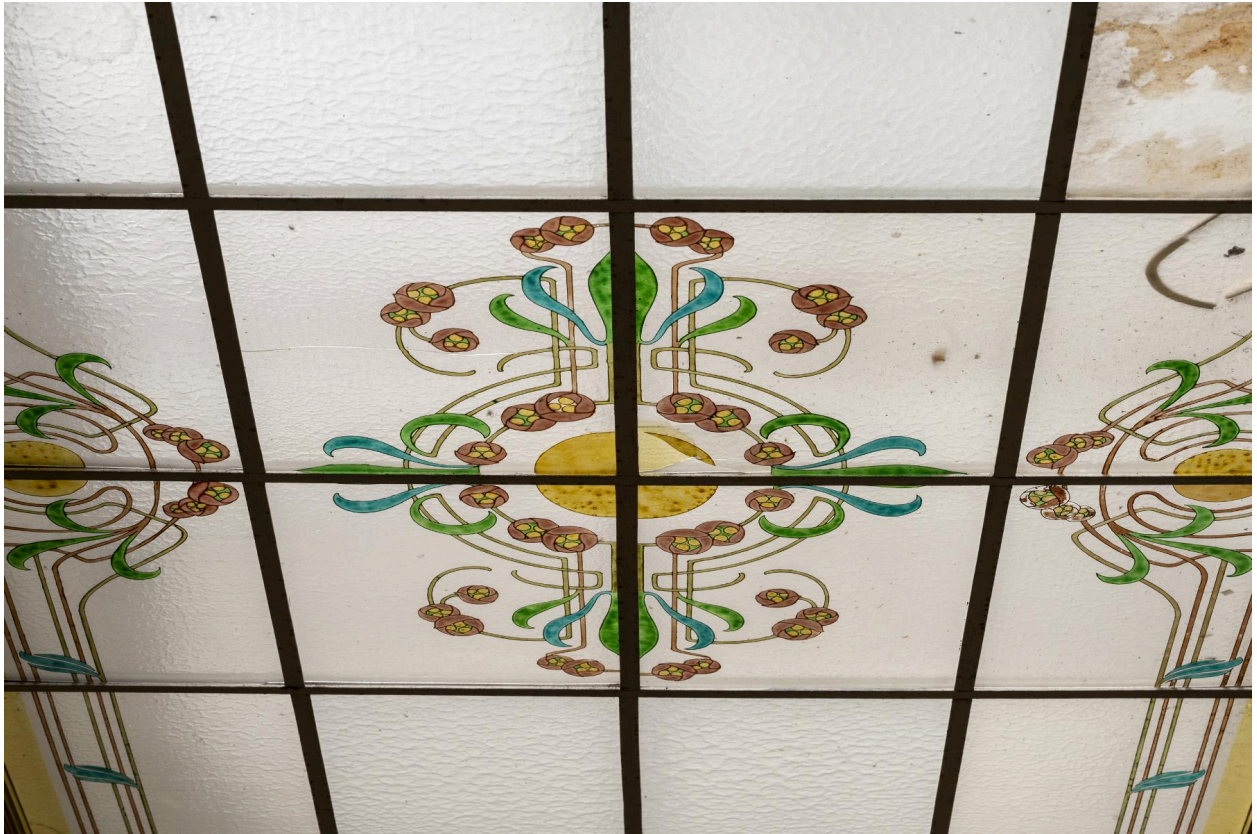
Détail de la verrière couvrant la salle à manger : motif central.
