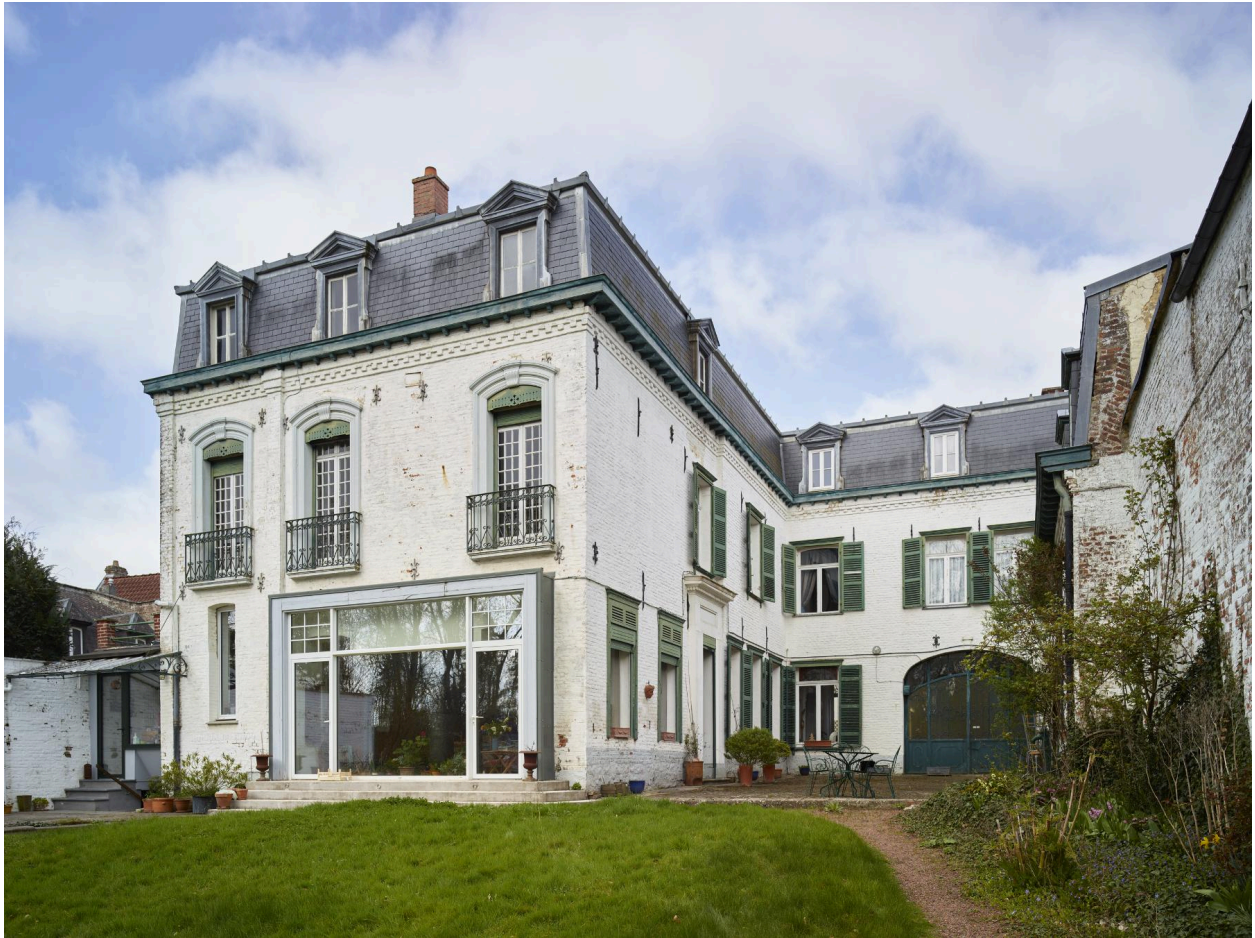
Vue générale de l'arrière de la maison depuis le jardin. Vue orientée sud-est/nord-ouest.
