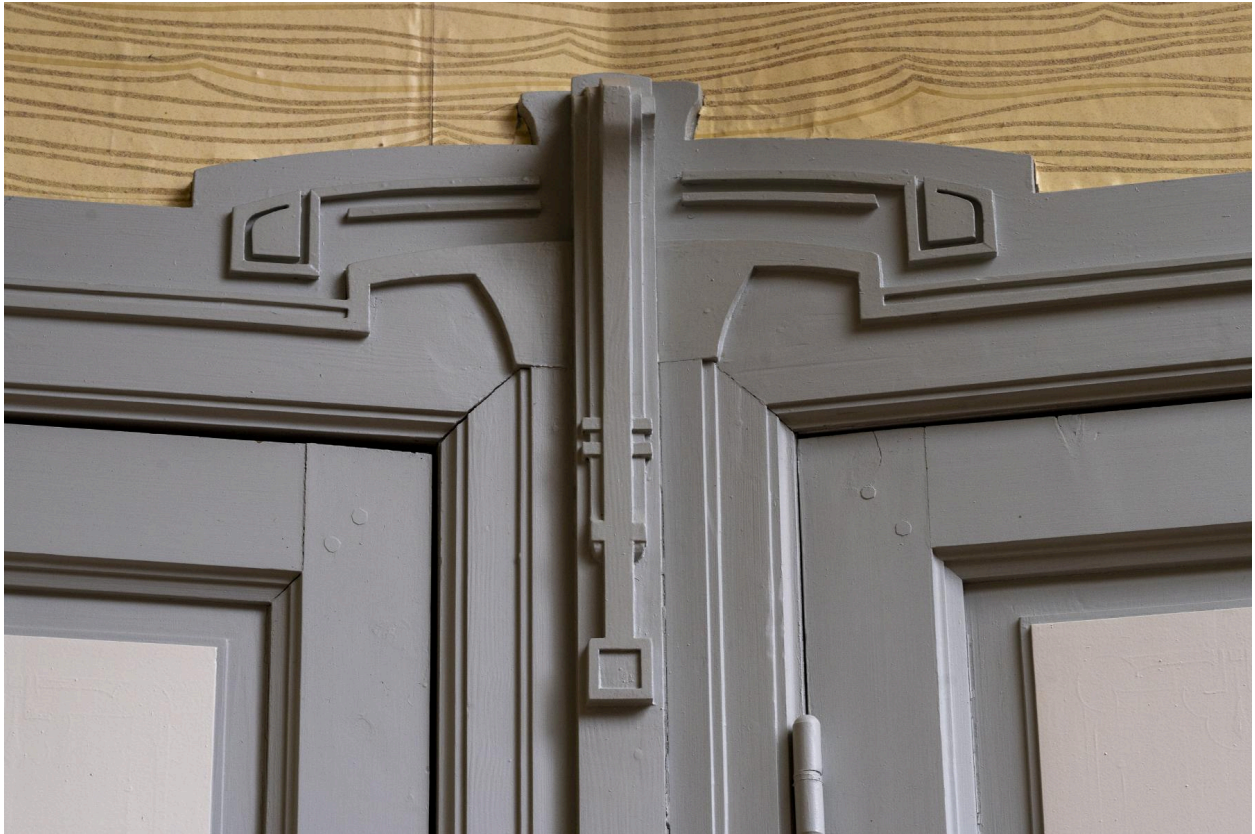
Détail des boiseries des placards situées à l'extrémité côté rue de la salle à manger.
