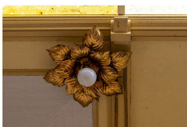
Détail d'un plafonnier. Phot. Pierre Thibaut IVR32_20255900247NUCA
