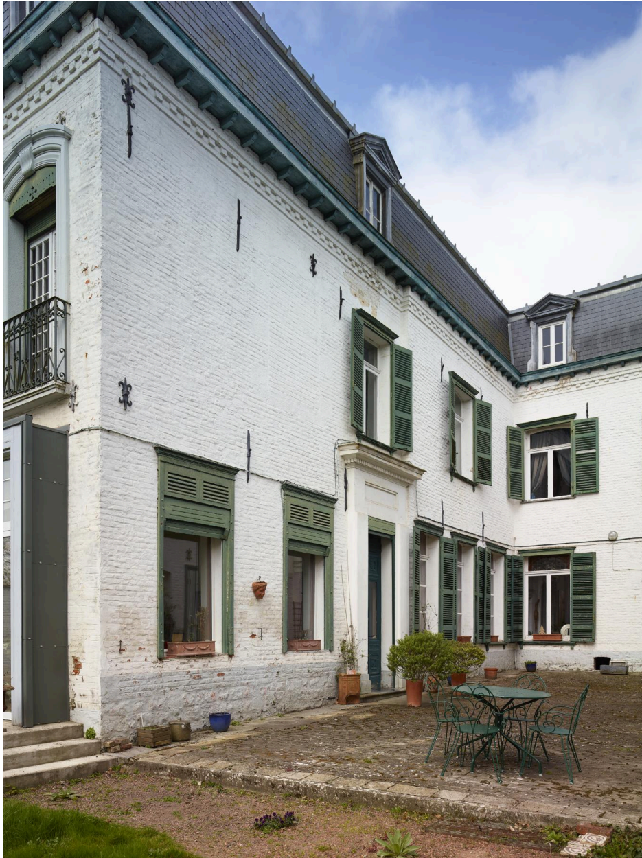
Détail de l'aile d'habitation et de l'arrière de la porte cochère (aile ouest) depuis la cour.
