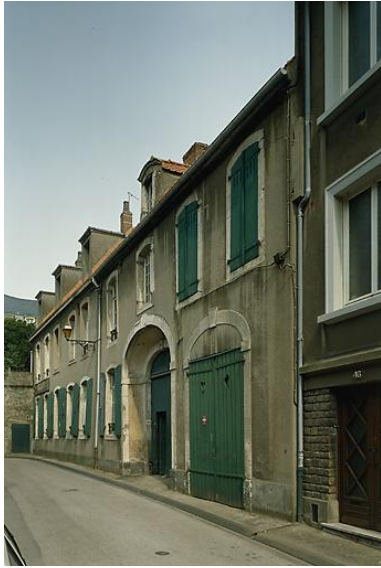
Façade sur voie. Phot. Jean-Michel Périn IVR31_19876201409XA
