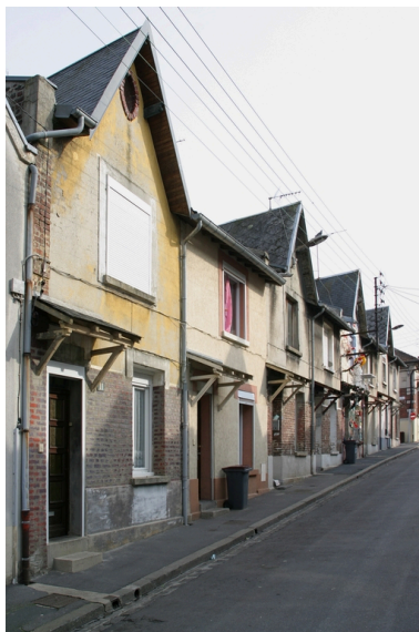
Les huit logements côté est. Phot. Frédéric Pillet IVR22_20060205095NUCA
