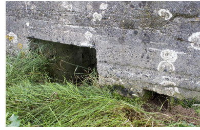
Détail de l'entrée nord. A sa droite un créneau de fusillade Phot. Jean-Marc Ramette IVR32_20165901478NUCA
