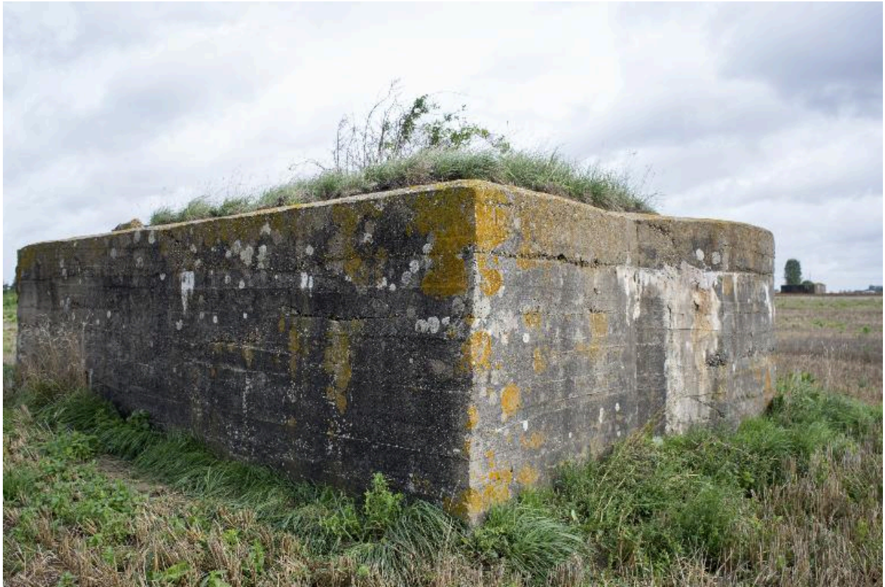
Vue de trois-quarts arrière, vers le nord
