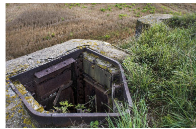
Poste d'observation cuirassé privé de son couvremnt Phot. Jean-Marc Ramette IVR32_20165901475NUCA
