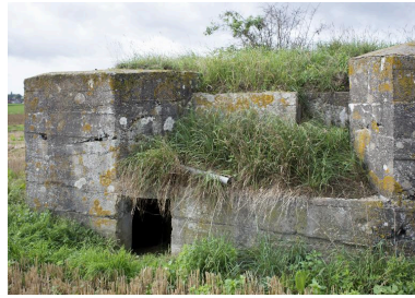
Elévation antérieure. Entrée et banquette de tir Phot. Pierre Thibaut IVR32_20165901471NUCA
