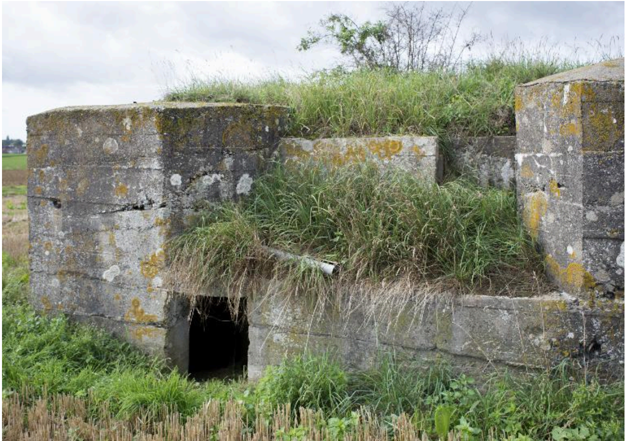
Elévation antérieure. Entrée et banquette de tir
