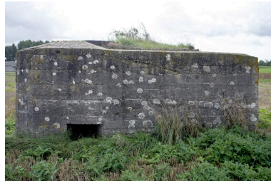
Vue latérale nord. Entrée surmontée d'ub poste d'observation cuirassé. Phot. Pierre Thibaut IVR32_20165901472NUCA
