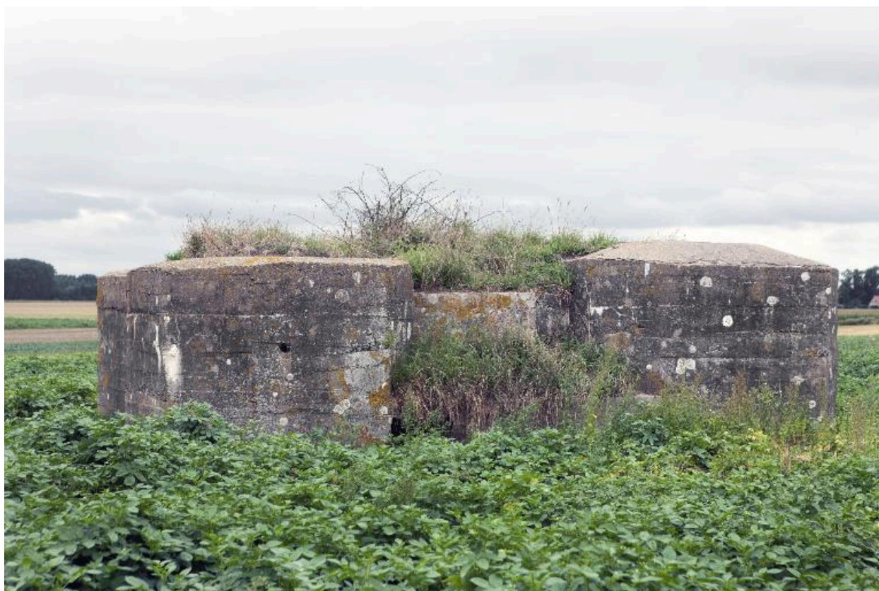
Elévation antérieure, vers l'ouest
