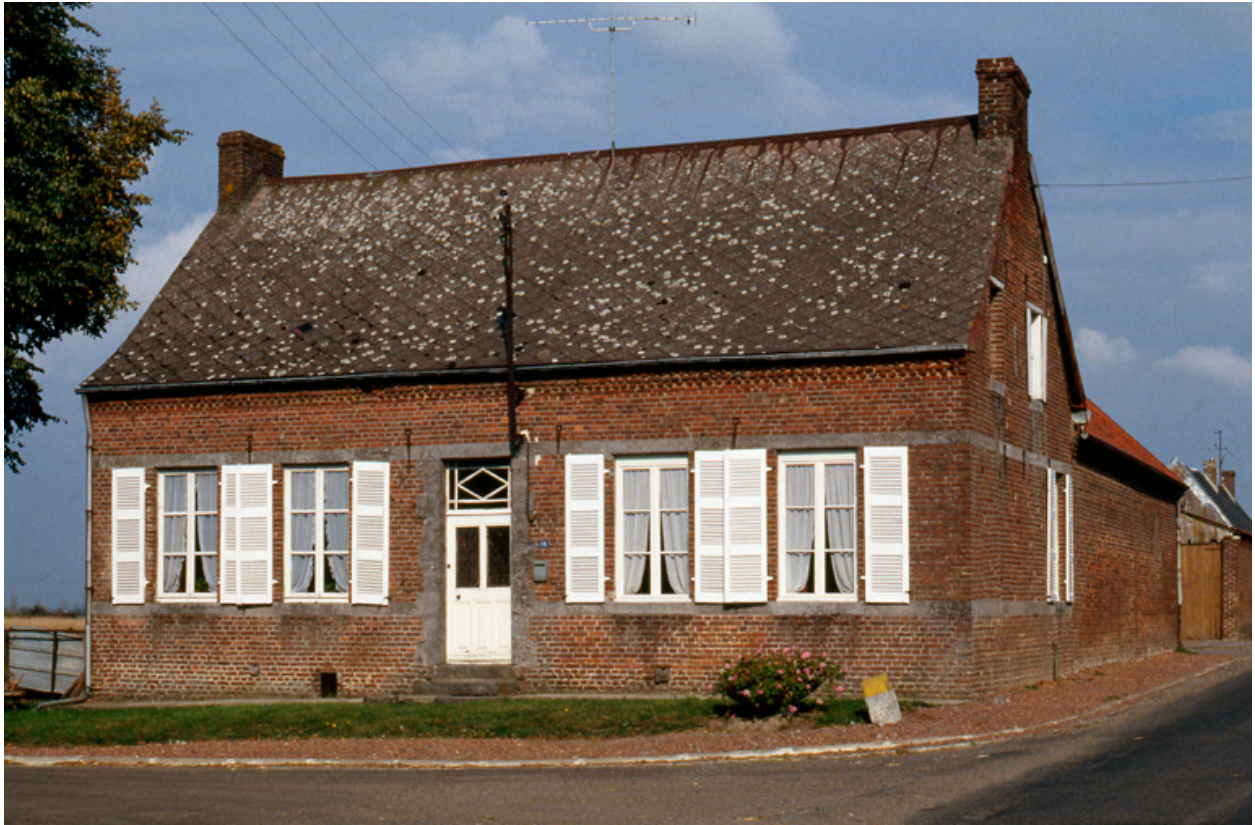
Wassigny. Logis de ferme.
