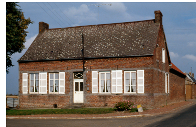
Wassigny. Logis de ferme. Phot. Christiane Riboulleau IVR22_19910201228ZA
