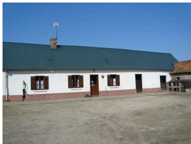
Vue du logis. Phot. Inès Guérin IVR22_20078005498NUCA
