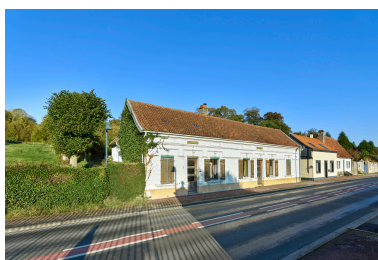
Vue de la maison, depuis l'ouest. Phot. Thierry Lefébure IVR32_20248001443NUCA
