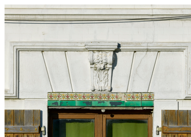
Détail des céramiques sous les linteaux des ouvertures. Phot. Thierry Lefébure IVR32_20248001444NUCA
