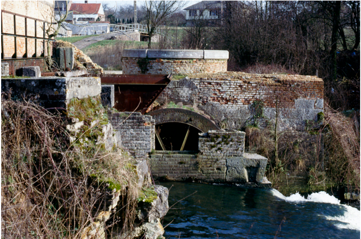
Détail de la meule et de la roue hydraulique verticale.
