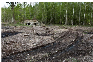
Vue générale vers le nord Phot. Jean-Marc Ramette IVR31_20146203097NUCA
