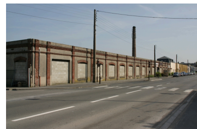
Vue de l'usine depuis le nord. Phot. Frédéric Pillet IVR22_20070205193NUCA
