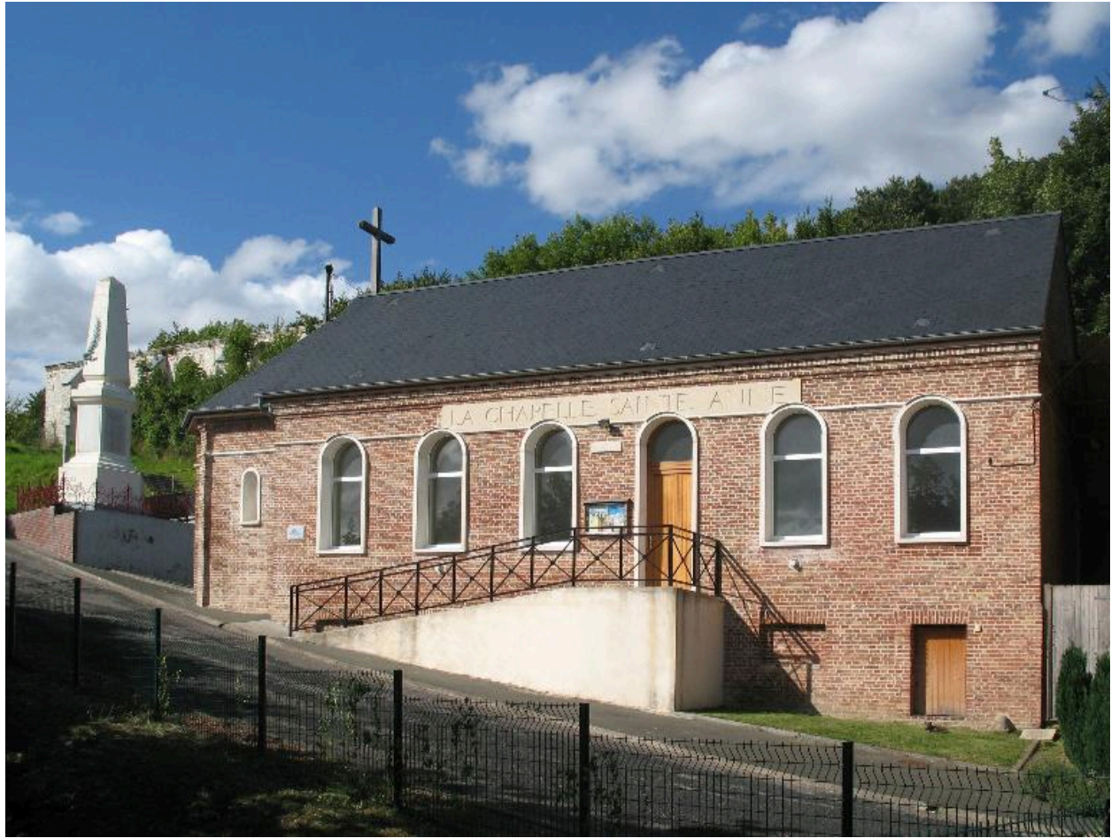
Façade principale sur rue.
