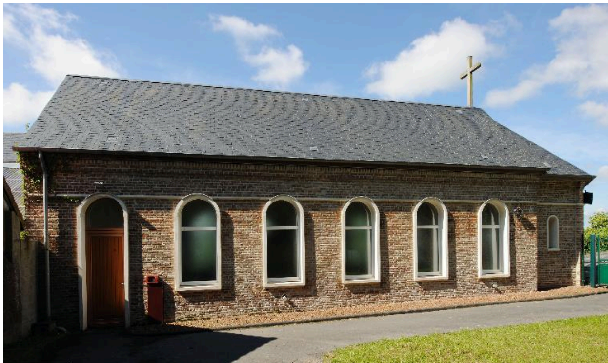
Façade sur cour.
