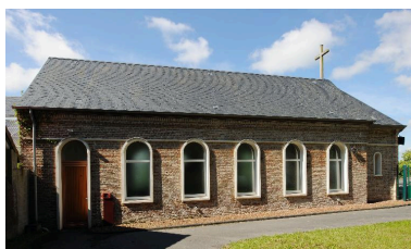
Façade sur cour. Phot. Thierry Lefébure IVR22_20128000326NUC2AQ
