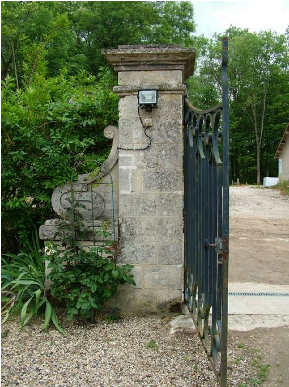
Pilastre du portail d'entrée.
