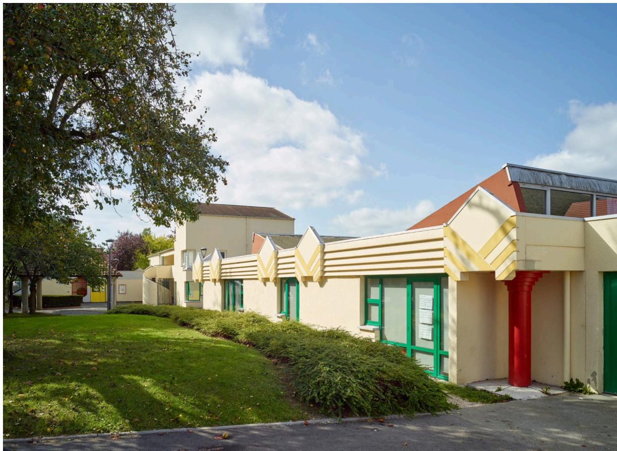
Vue depuis l'angle des rues de la Convention et de la Coutume.
