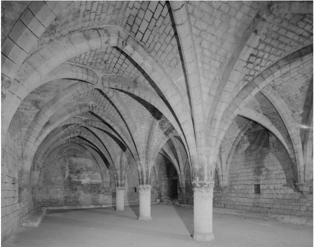
Le cellier. Vue intérieure vers le sud.
