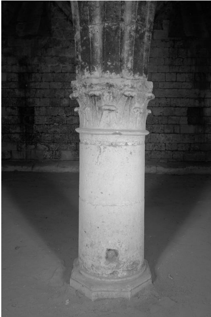
Le cellier. Vue du pilier central n°2.
