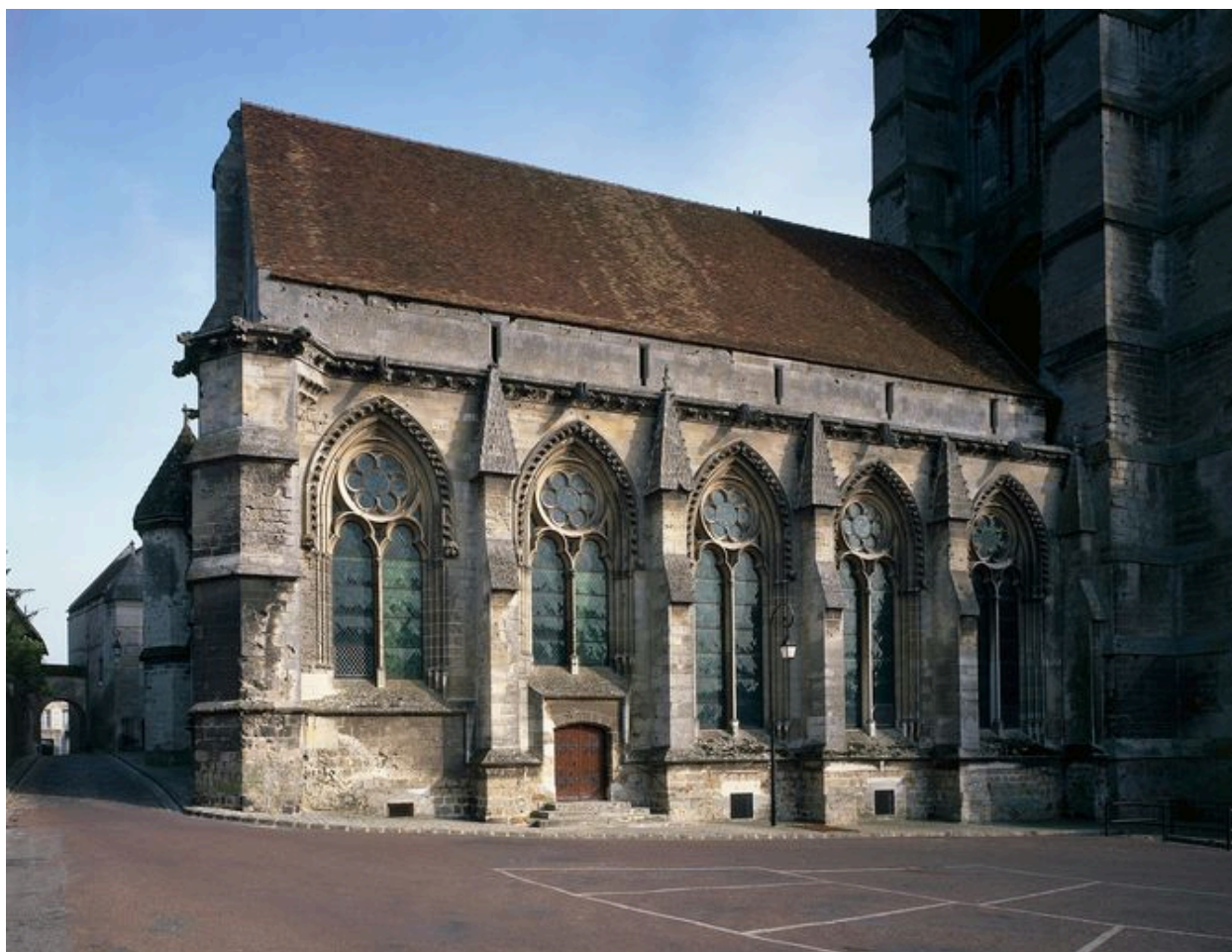
La salle capitulaire. Vue de la façade ouest.
