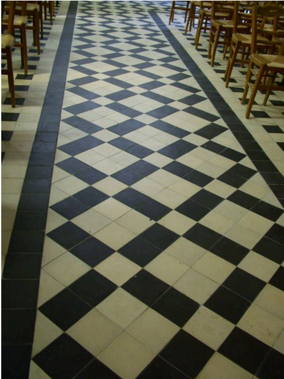
Vue partielle du carrelage en damier de l'église.
