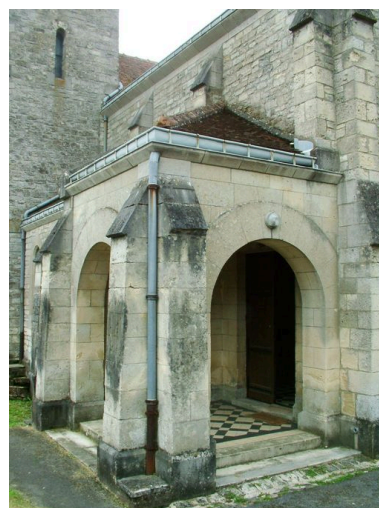
Entrée actuelle de l'église. Phot. Inès Guérin IVR22_20030202324NUCA
