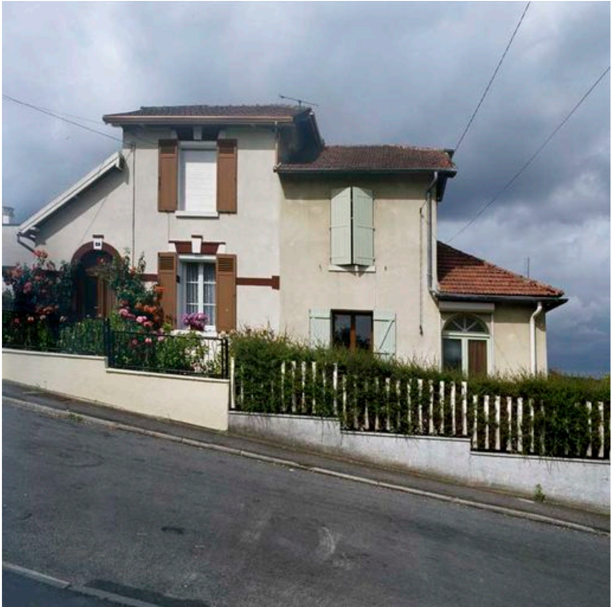
Logements jumelés de la cité Mimbertain.
