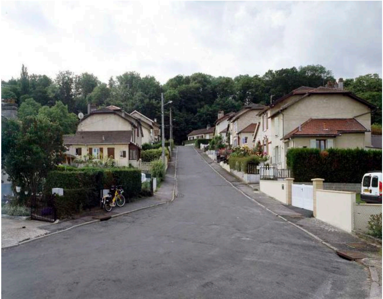
Vue générale de la cité Mimbertain.
