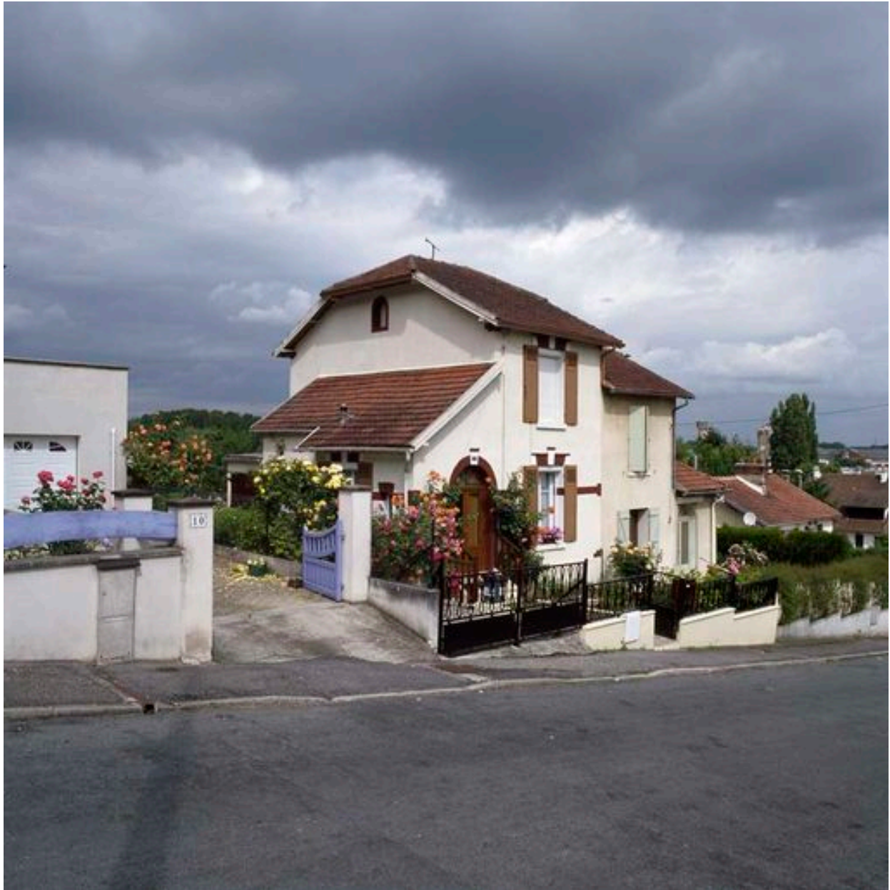
Logements jumelés de la cité Mimbertain.
