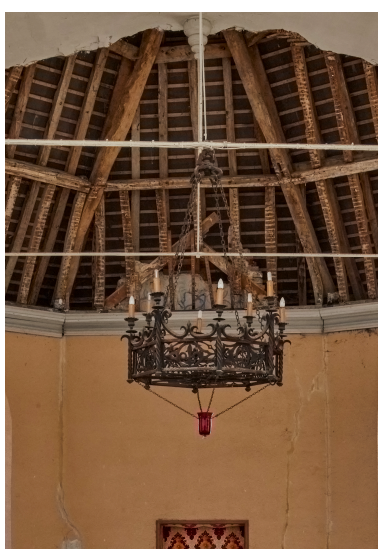
Lustre dans le chœur. Phot. Thierry Lefébure IVR32_20258002151NUCA
