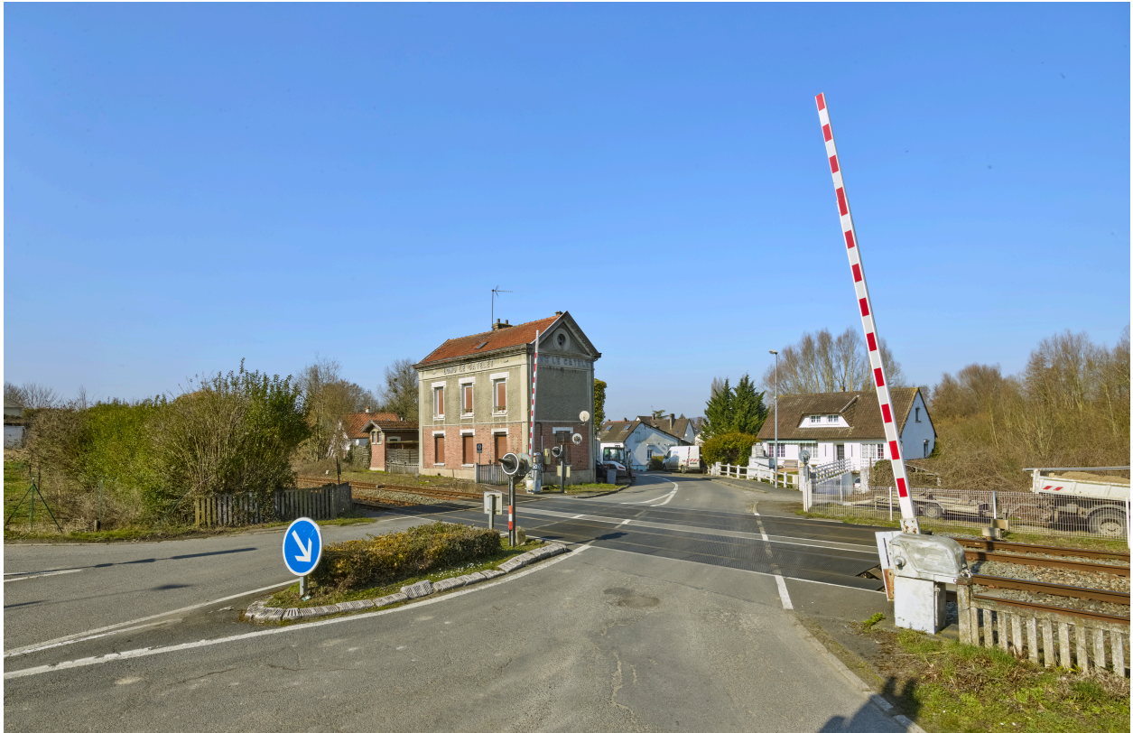
Vue de l'ancienne halte et du passage à niveau, depuis le sud-est.
