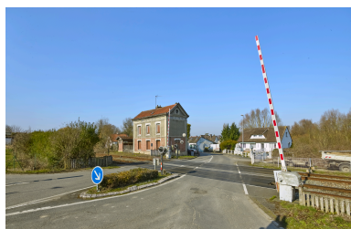
Vue de l'ancienne halte et du passage à niveau, depuis le sud-est.
