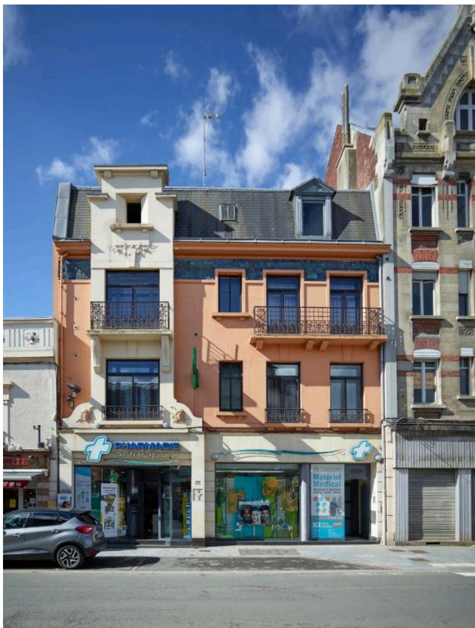
Vue générale depuis la rue de Péronne.
