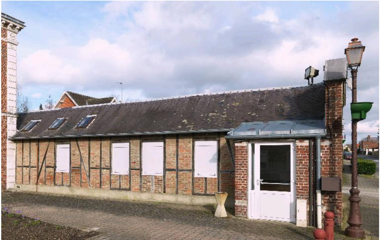
Vue générale des anciennes dépendances attenantes.
