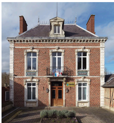
Façade sur cour.
