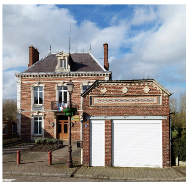
Garage aménagé dans l'ancienne dépendance.
