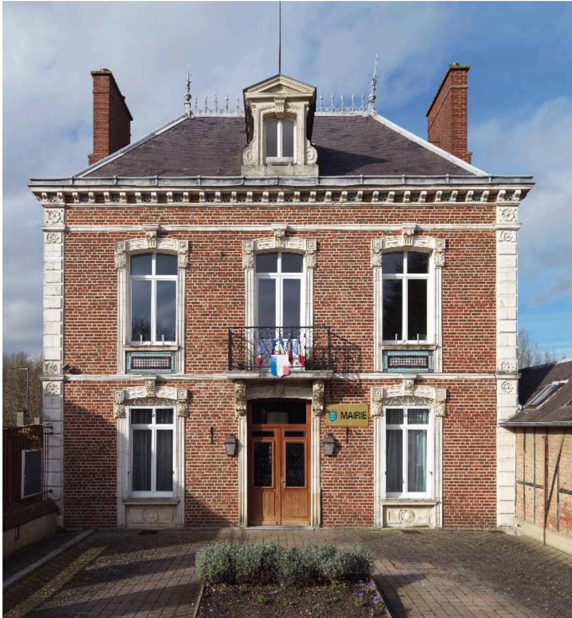
Façade sur cour.
