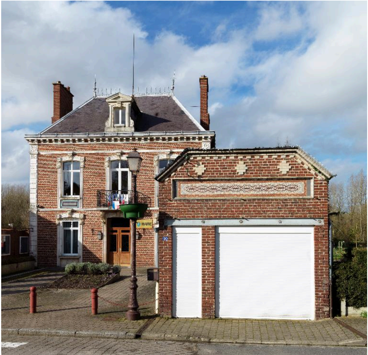
Garage aménagé dans l'ancienne dépendance.
