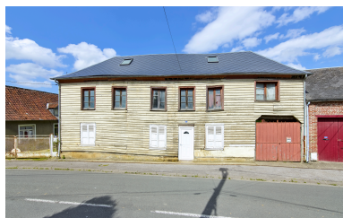
Vue de la maison, depuis le sud-ouest. Phot. Thierry Lefébure IVR32_20248000930NUCA
