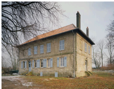
Elévation antérieure. Phot. Fabrice Charrondière IVR22_19866000043VA
